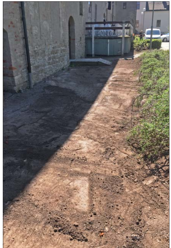
Figur 7. Efter igenläggningen av schaktet. Foto från norr av Helén Romedahl, ÖM.
