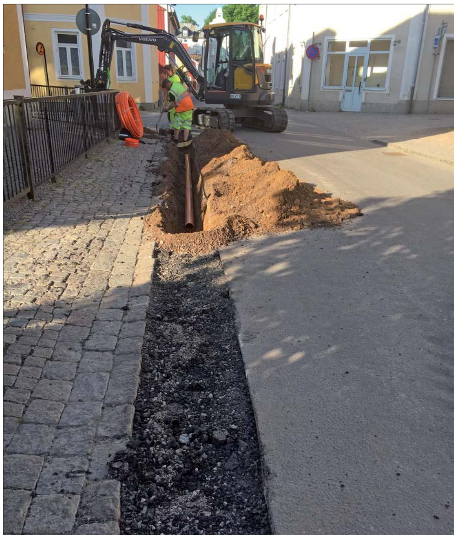
Figur 3. Schaktet i Knivsmedsgatan. Foto mot väster, Helén Romedahl, ÖM.
