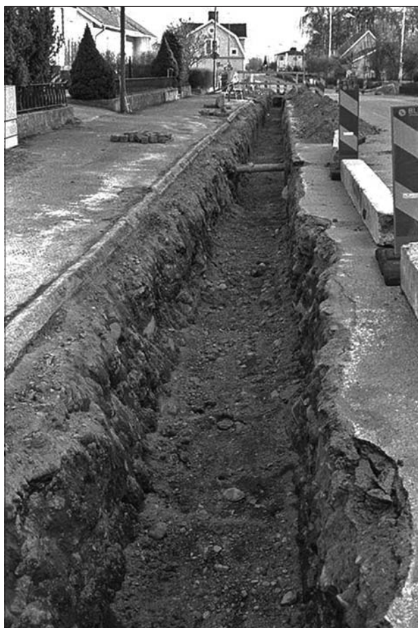
Figur 6. Schaktet i Motalagatan sett från korsningen med Klostergatan. Foto mot SV.
