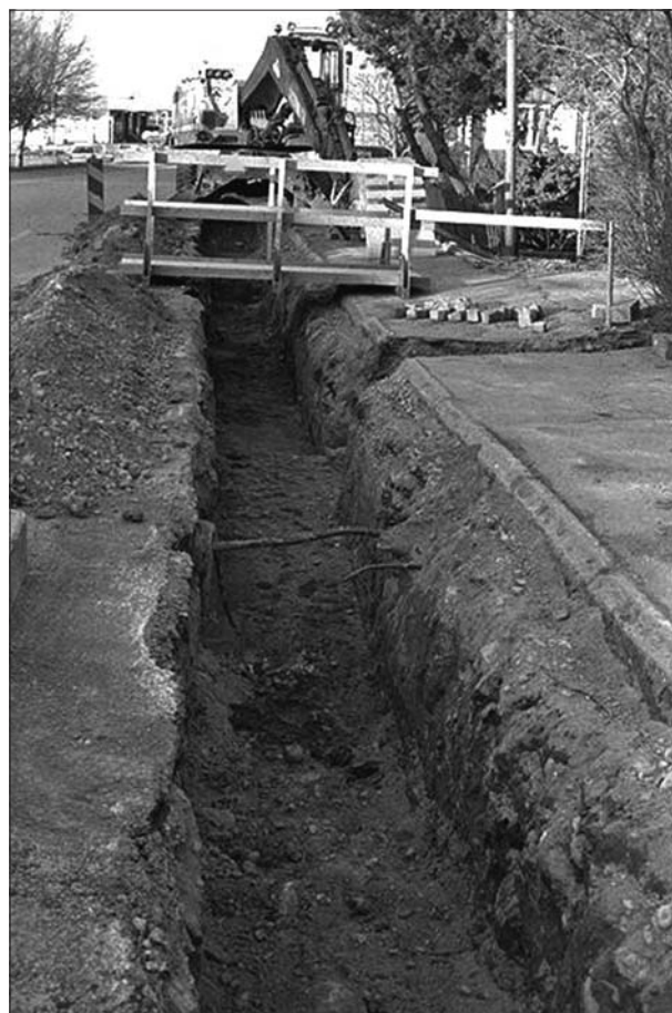
Figur 7. Schaktet i Motalagatan sett från korsningen med Klostergatan. Foto mot NÖ.
