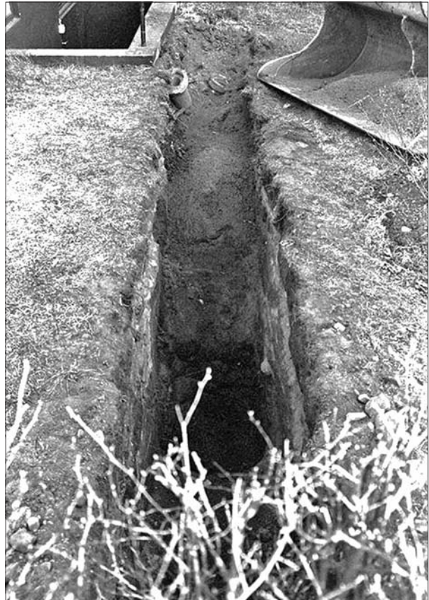
Figur 10. Schaktet in i kv Abboten 8. Foto mot Ö.
