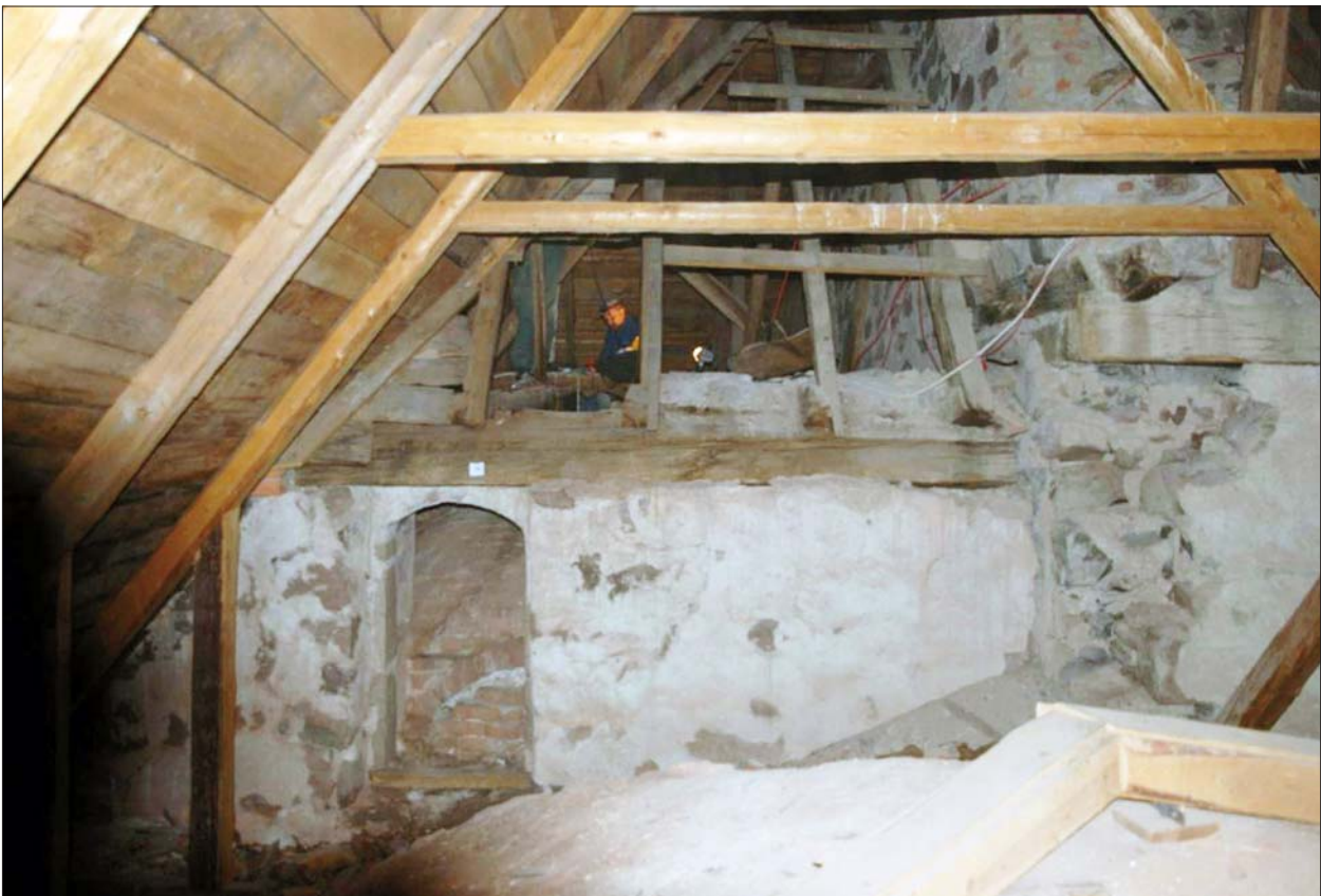
Figur 8, nedan. Öppningen mellan sakristia och kor är placerad högt upp på det ursprungliga korets norra fasad. I förgrunden ses sakristians valv. Ur Nordanskog 2010.
