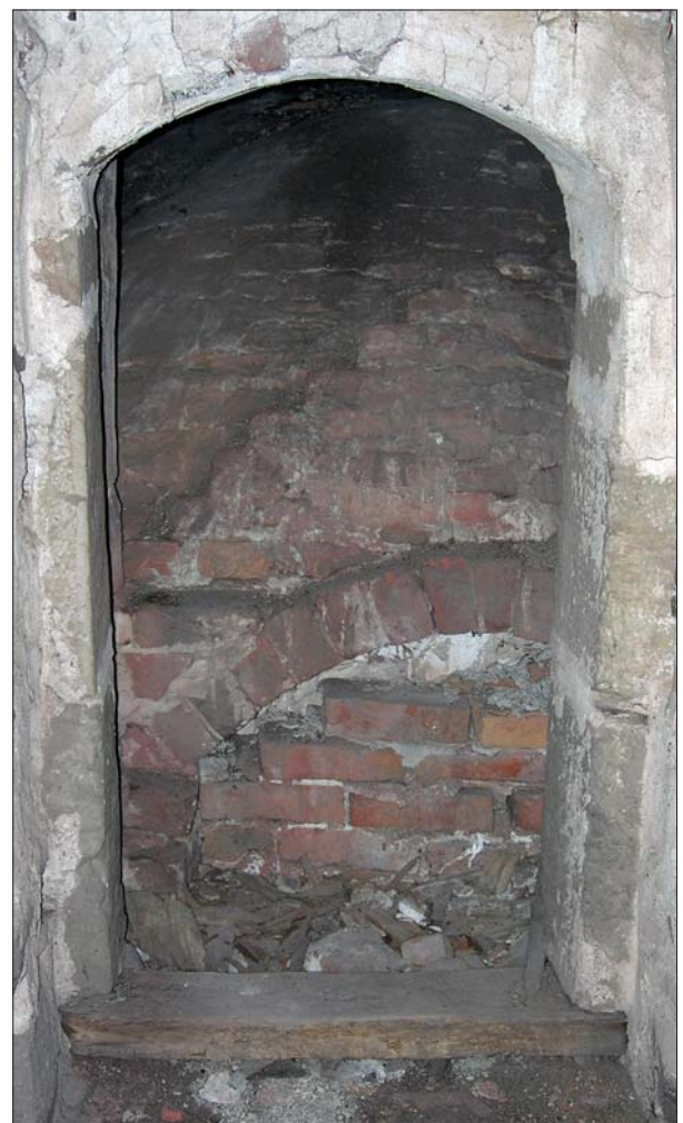
Figur 5. Öppningen mellan sakristia och kor sett från sakristian. Bakom öppningen ses korets valv som slogs under 1400-talet. Foto Anders Lundberg, ÖLM.
