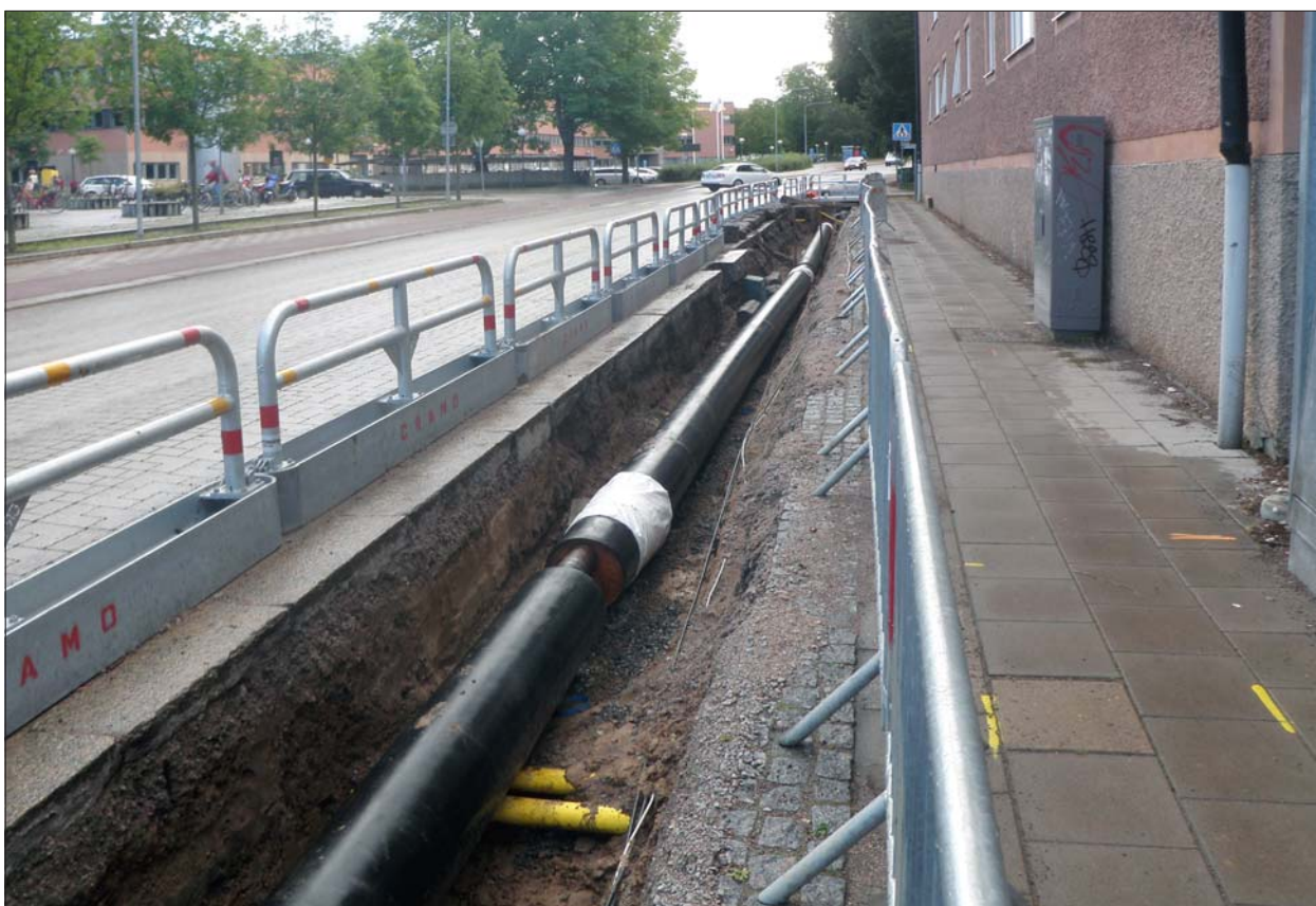
Figur 11, nedan. Delsträcka 5. De bevarade kulturlagren sträckte sig fram till de tvärgående elledningarna (gula) som syns i schaktbotten. Söder om dessa fanns inga kulturlager bevarade, bild från norr. Foto Olle Hörfors, ÖLM.
