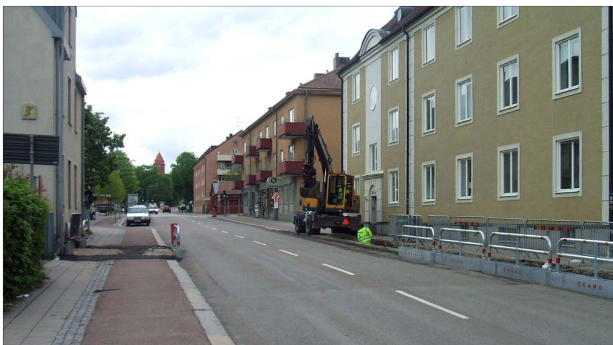
Figur 5, överst. Schaktsträcka 1 från norr. Foto Olle Hörfors, ÖLM.
