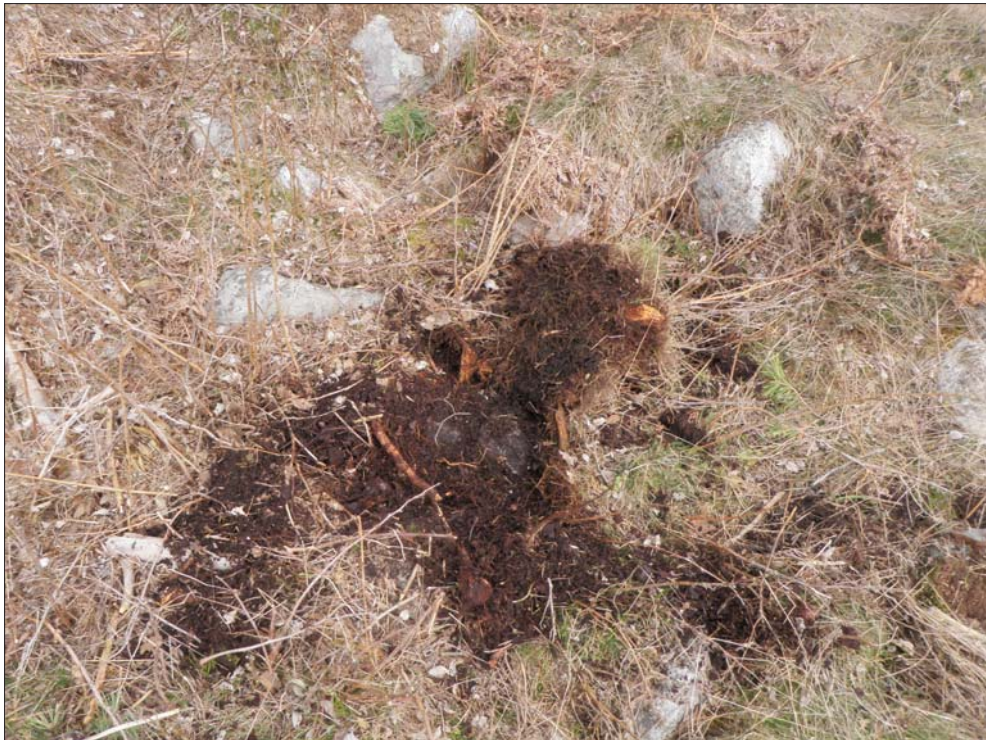
Fig 14. Den intakta skärstenspackningen skymtar i det mörkare framrensade partiet av den centrala skadan i SR 5.
