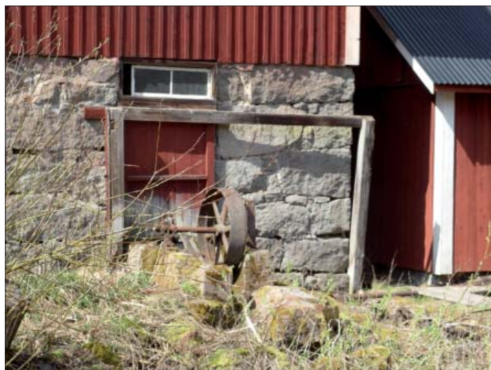
Figur 33. Delar av transmissionen är bevarad samt öppning in till kvarnbyggnaden för kraftöverföring. Foto Marie Hagsten, ÖM.
