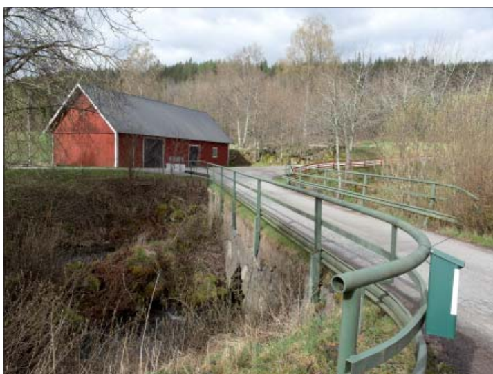
Figur 17. Södergårdens ladugård och stenvalvsbron med två spann. Foto från ostnordost, Marie Hagsten, ÖM.
