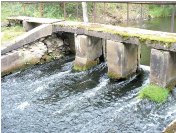
Figur 72. Dammfästet är gjutet med en äldre teknik som innehåller mycket grova stenar. Foto från nordväst, Marie Hagsten, ÖM.
