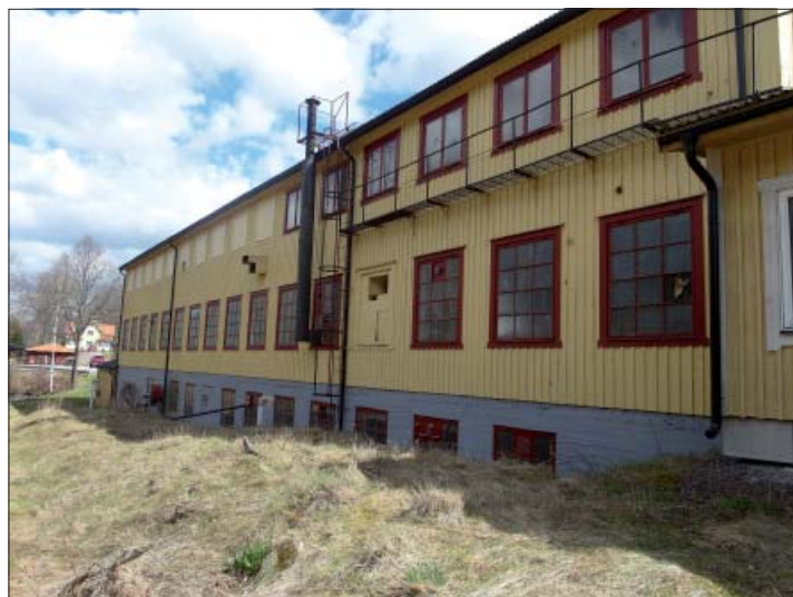
Figur 38. Fabriksbyggnadens västra fasad ut mot ån. Foto från sydväst, Marie Hagsten, ÖM.
