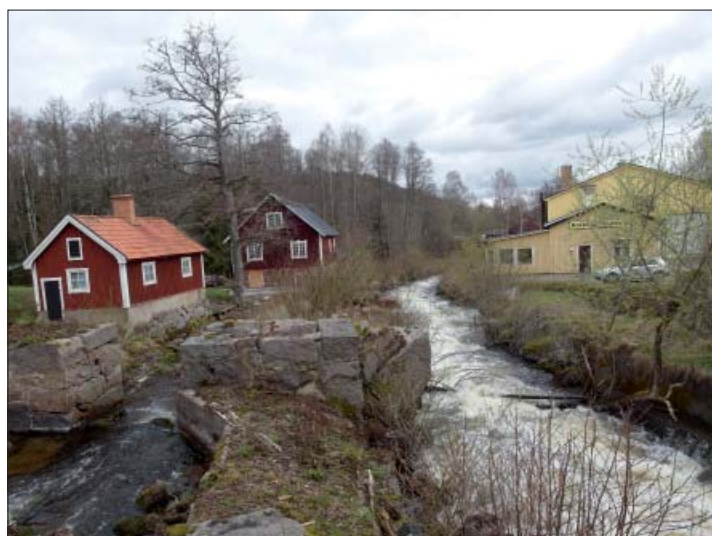
Figur 23. Gjuten ledarm och äldre dammfäste av bearbetad granit. I bakgrunden ses bryggghus och kvarnbyggnaden tillhörande Falklyckan. Till höger syns byggnad tillhörande fd yxfabriken (se vidare nedan). Foto från söder, Marie Hagsten, ÖM.
