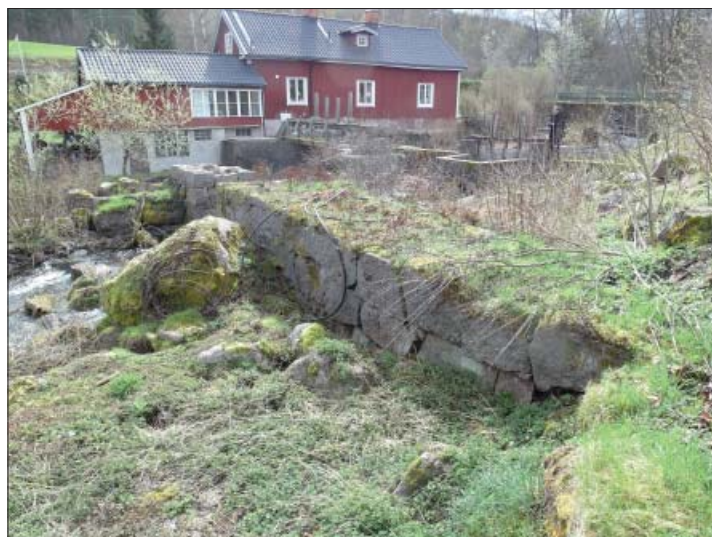
Figur 21. Äldre dammfäste av bearbetad granit. Foto från västnordväst, Marie Hagsten, ÖM.
