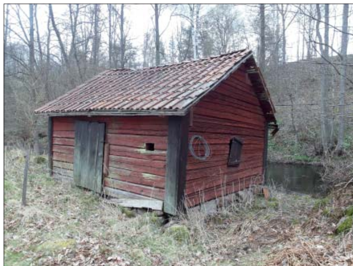
Figur 65. Brygghuset har två dörrar och är timrat. Foto från väster, Marie Hagsten, ÖM.
