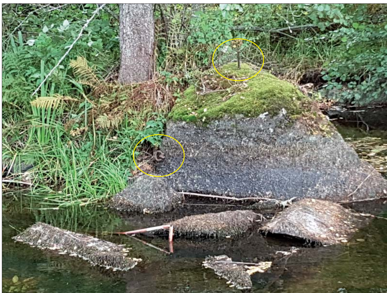
Figur 9. L2018:115 utgörs av ett länsfäste i form av en i stenblock fastslagen järnbult med intilliggande järnögla. Lokalen är belägen mitt i Storån och mellan de två stenvälsbroarna något uppströms från Kölefors. Foto från sydväst, Kjell Svarvar, ÖM.
