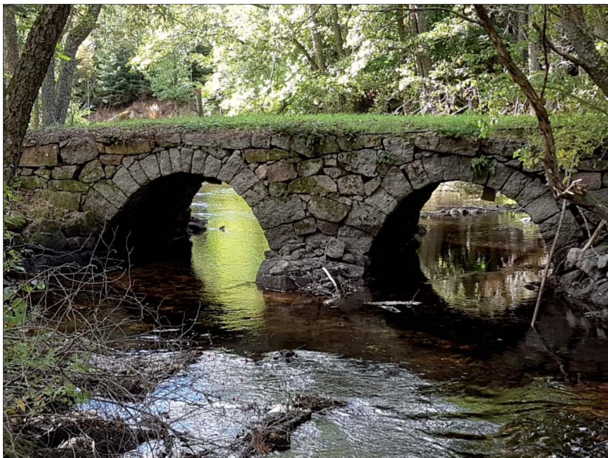
Figur 79. Stenalvsbron RAÄ-nr. Västra Eneby 144:1 bestående av två valv, sedd från nordöst. Bron, kallad Nybro, uppfördes år 1790 av Enebyborna (Aineström 1982:386) efter det att landsvägen ändrat sträckning till att endast löpa på västra sidan om Storån. Tack vare denna broöverfart kunde allmogen från Västra Eneby lättare ta sig till allmänna landsvägen, som efter 1780-talet kom att löpa på västra sidan av ån. Foto Kjell Svarvar, ÖM.
