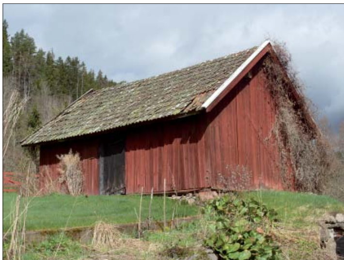
Figur 29. Vedbod som står på jordkällaren. Foto från sydöst, Marie Hagsten, ÖM.
