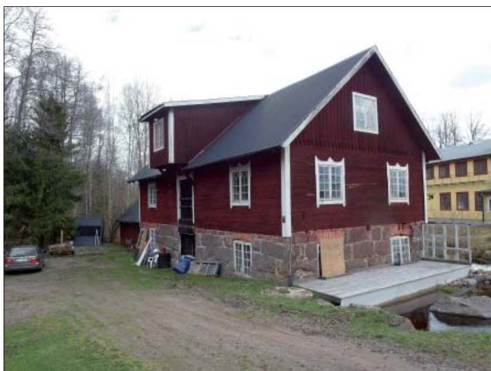
Figur 31. Kvarnbyggnaden till Falklyckan. Foto från sydväst, Marie Hagsten, ÖM.
