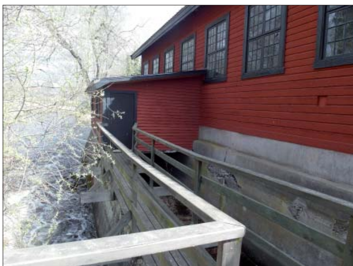
Figur 46. Intagsrännan till smedjans turbinhus. Foto från sydväst, Marie Hagsten, ÖM.
