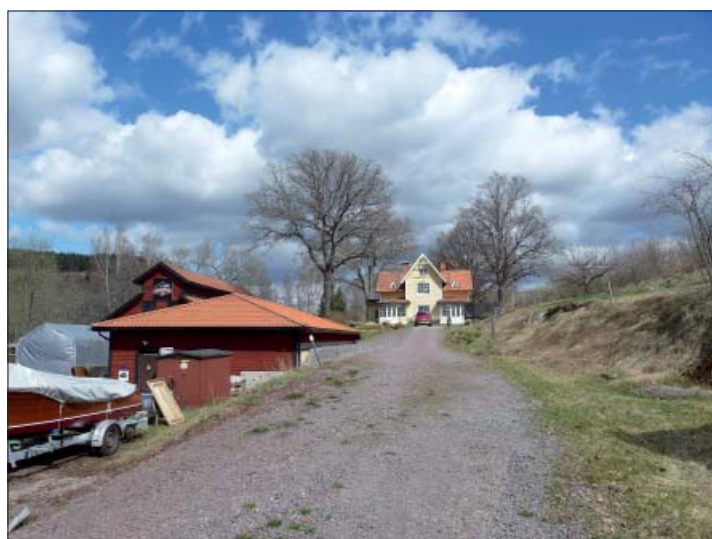
Figur 53. Villan och en nybyggd lackeringsverkstad. Till vänster syns taket på smedjan. Foto från söder, Marie Hagsten, ÖM.
