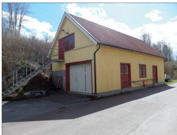
Figur 41. Verkstad/garage beläget öster om fabriksbyggnaden. Foto från nordnordväst, Marie Hagsten, ÖM.
