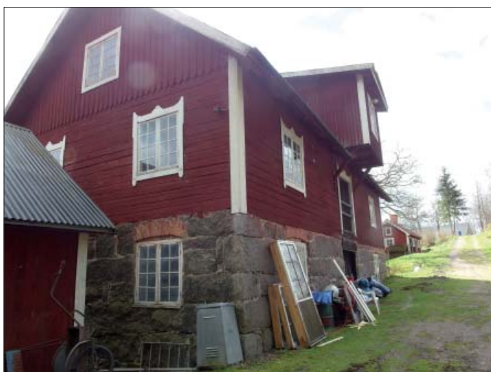
Figur 32. Kvarnbyggnaden med bryggshuset och tillfartsvägen i bakgrunden. Till vänster i bild skymtar sågbyggnaden. Foto från nordnordväst, Marie Hagsten, ÖM.
