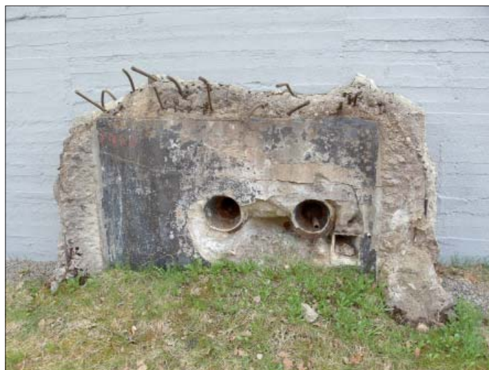
Figur 39. Spår efter kraftöverföring i västra fasaden. Foto Marie Hagsten, ÖM.
