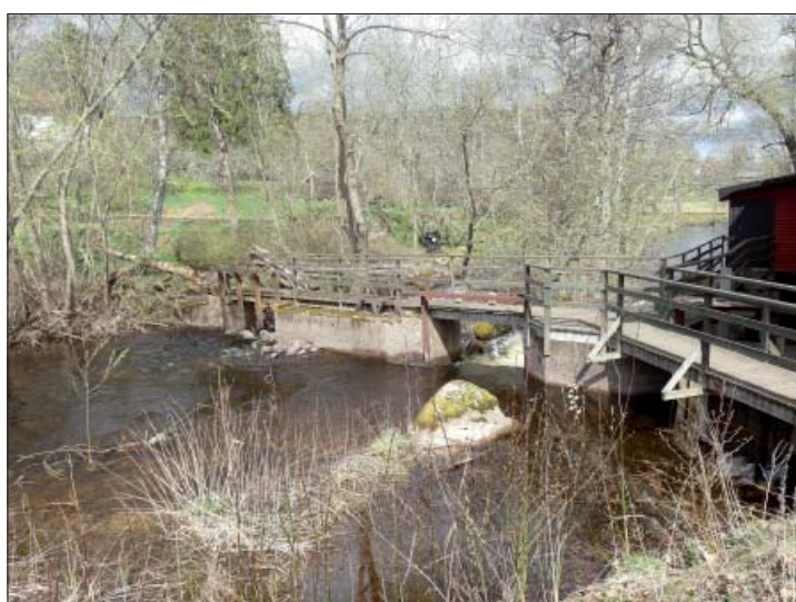
Figur 43. Gjutet dammfäste med två luckor. Den högra leder in vatten i smedjans turbinhus. Foto från söder, Marie Hagsten, ÖM.
