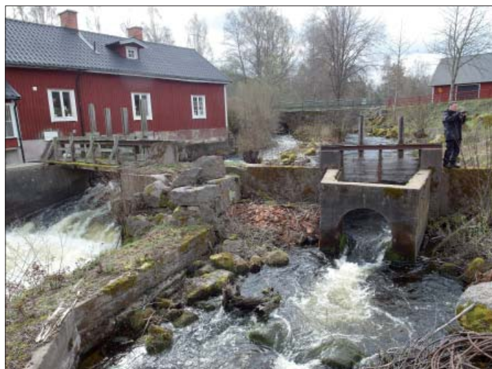
Figur 14. Dammfäste med två luckor samt ledarm mellan Kölefors Södergårdskvarn och Falklyckan. Foto från nordnordväst, Marie Hagsten, ÖM.
