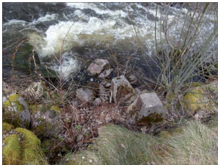
Figur 40. Gjutna fundament efter turbinhus. Foto Marie Hagsten, ÖM.
