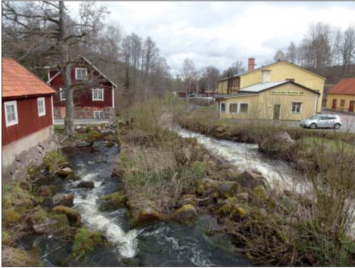
Figur 24. Utrasad intagsränna där den tidigare turbintrumman förde in vattnet i kvarnen. Foto från söder, Marie Hagsten, ÖM.
