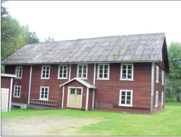
Figur 70. Kölefors Vaddfabrik. Foto från nordväst, Marie Hagsten, ÖM.
