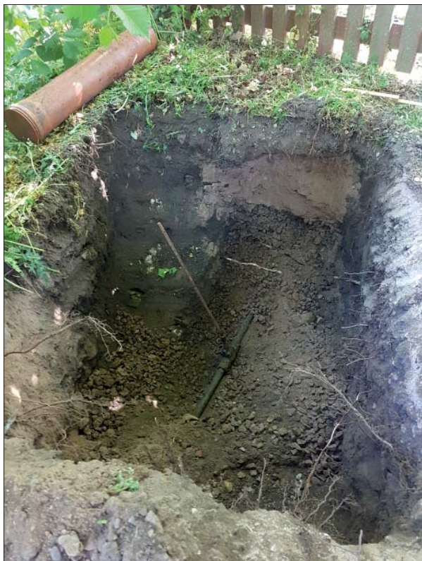
Figur 6. Schaktet sett från väster. Foto Ann-Charlott Feldt, ÖM.
