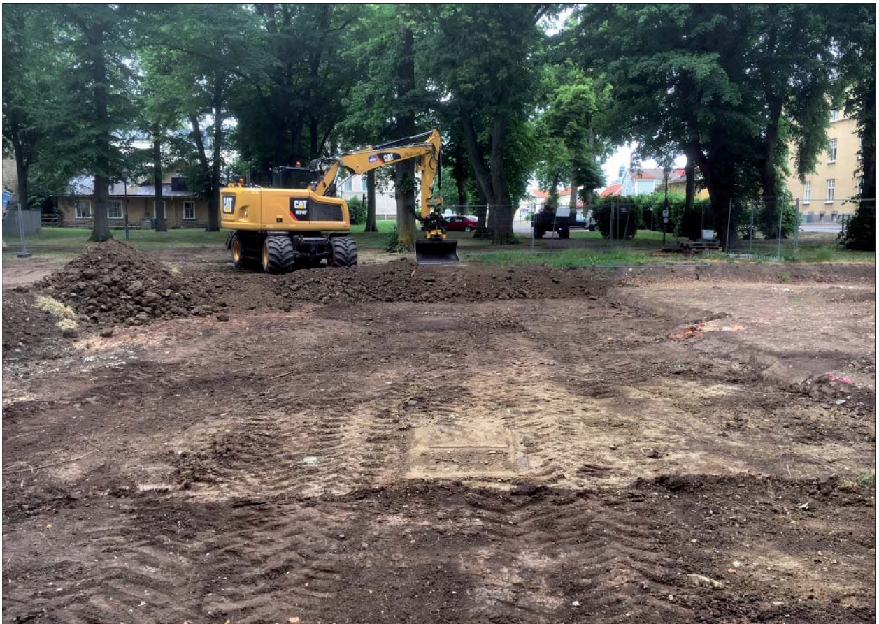
Figur 9. Sommaren 2018. Bortschaktning av föroreningar - genom gamla tennisbanans mitt. Foto mot norr, Helén Romedahl, ÖM.
