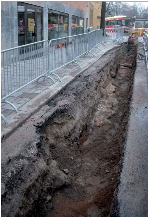
Figur 11. Den södra schaktsträckan i Storgatan. Mot väster. Foto: Mats Magnusson, ÖM.
