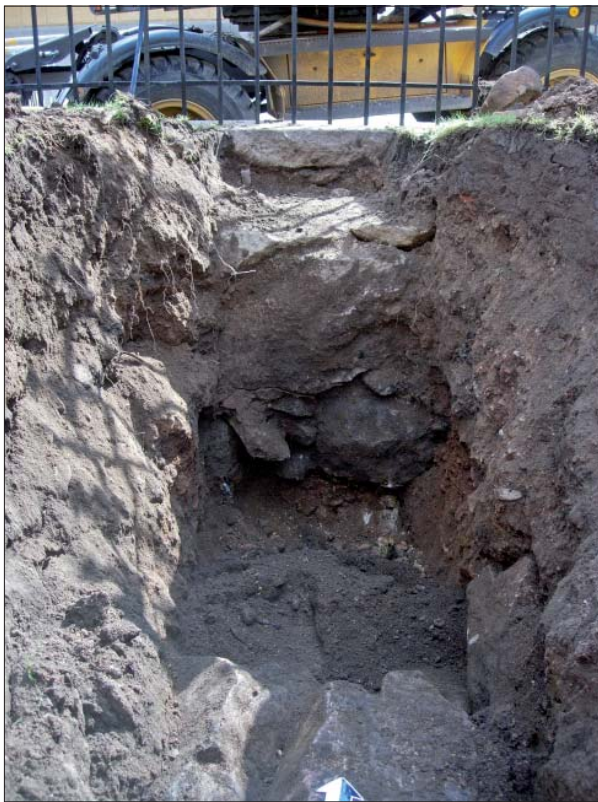
Figur 23. I anslutning till stödmuren grävdes ett djupare schakt i syfte att dra ledningen under muren. I förgrunden syns den äldre muren. Mot söder. Foto: Mats Magnusson. (OBS! Felaktig norrpil på fotot)
