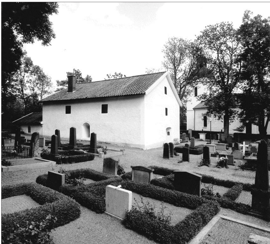
Figur 3. S:t Olofs kapell i Gryt sett från sydväst med den nya kyrkan i bakgrunden. Foto Arne Gustafsson, Bild E47996, Topografiska arkivet, Östergötlands museum.
