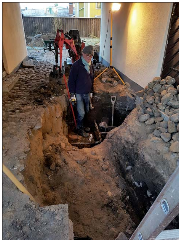
Figur 6. Schaktning inne i portlidret. Foto mot öster, Helén Romedahl, ÖM.
