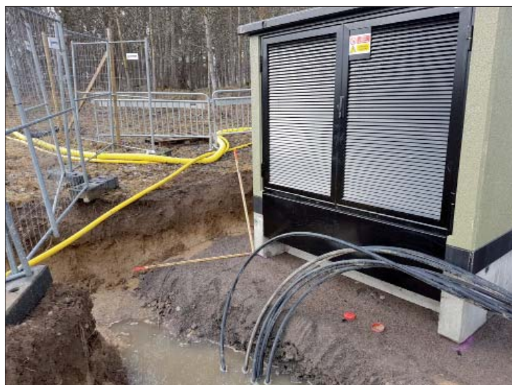
Figur 4. Nätstationen har placerats på sin bädd och i schaktkanten syns odlingsjorden över den naturliga undergrunden. Foto Ann-Charlott Feldt, ÖM.
