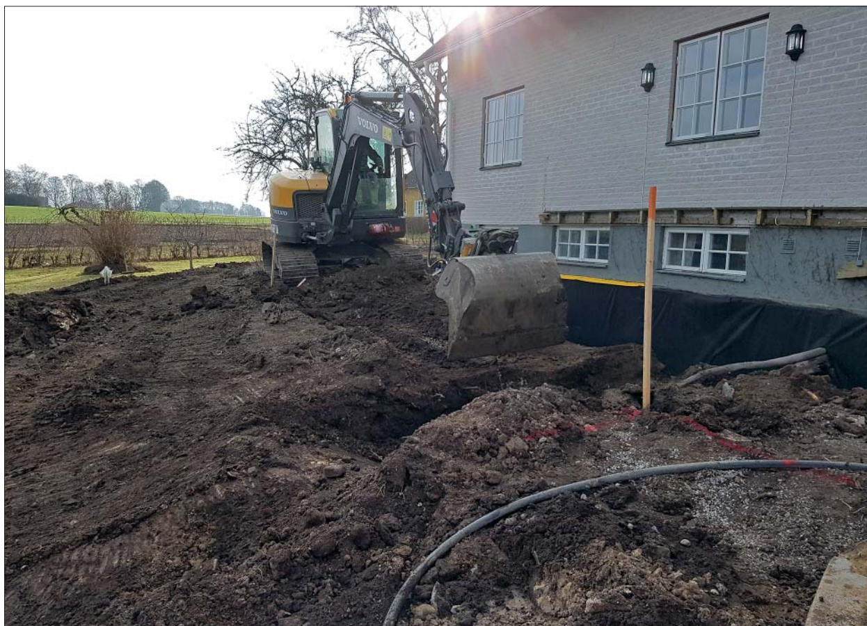
Figur 5. Arbetsbild, schaktning. Foto mot SÖ, Anders Olofsson, ÖM.
