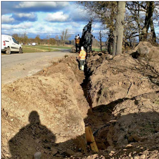
Figur 6. Schakt 27:1. Foto mot norr, Mats Magnusson, ÖM.
