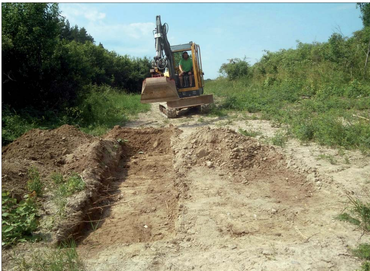
Figur 4. Schakt S225 under framschaktning. Foto mot SV, Roger Lundgren, ÖM.
