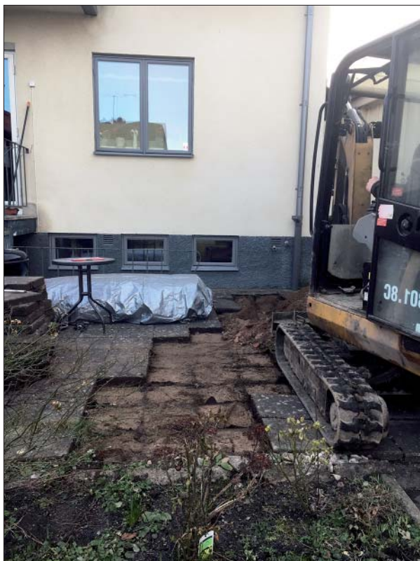
Figur 4. Schaktet på tomten. Foto från nordväst, Helén Romedabl, ÖM.
