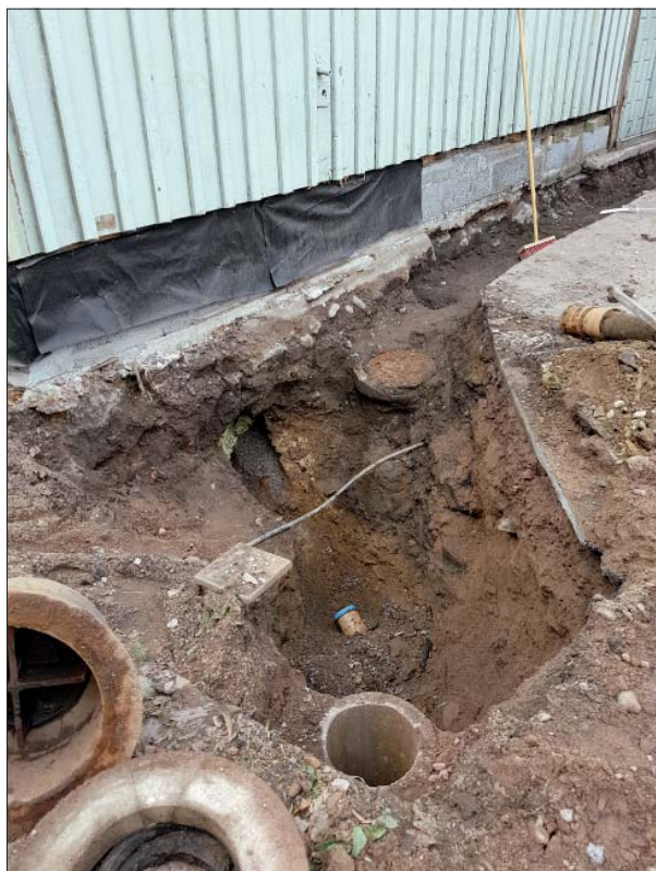
Figur 6. Schaktet för avloppet sett från Stockmakaregatan i öster. Längst bort i bilden syns en äldre dagvattenbrunn som framkom på ca 0,3 m djup under markytan. Foto Ann-Charlott Feldt, ÖM.
