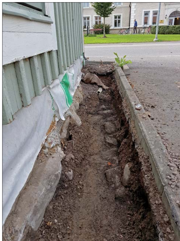
Figur 7. Stenläggningen i schaktet längs byggnadens nordvästra sida. I bakgrunden ses Slotts-gatan och bebyggelsen i kv Asylen. Foto Ann-Charlott Feldt, ÖM.
