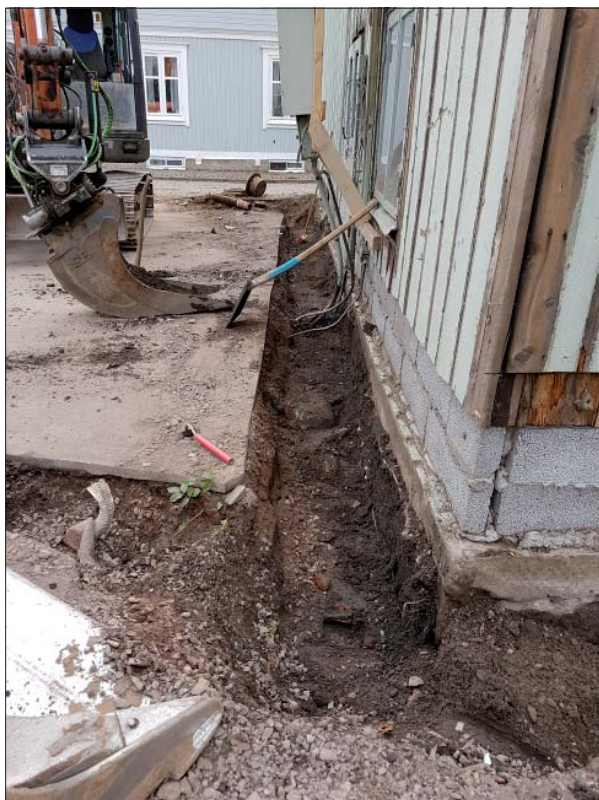
Figur 8. Schaktet på byggnadens nordöstra sida sett från nordväst. Schaktet grävdes ner till ytan på ett omrört kulturlager. Foto Ann-Charlott Feldt, ÖM.
