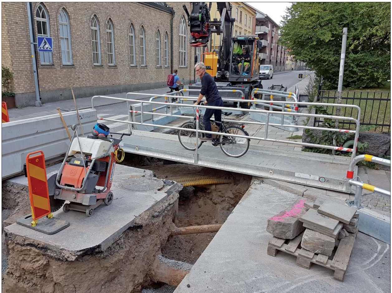
Figur 11. Schaktet i Ågatan. Foto från söder, Helén Romedahl, ÖM
