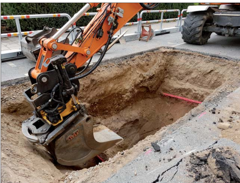
Figur 6. Schaktet sett från nordöst med grus- och sandlagren i den södra schaktväggen synliga. Foto Ann-Charlott Feldt, ÖM.
