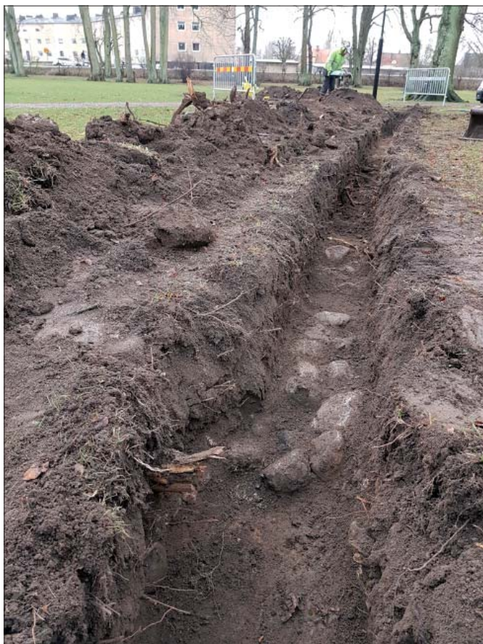
Schakt 2 med stenläggningen A276 i förgrunden. Foto mot söder, Emma Karlsson, ÖM.
