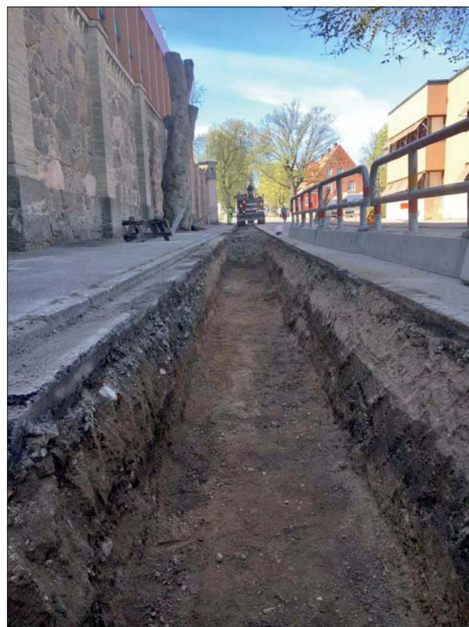
Figur 4. Schaktet i Gröngatan. Foto från öster, Helén Romedahl, ÖM.
