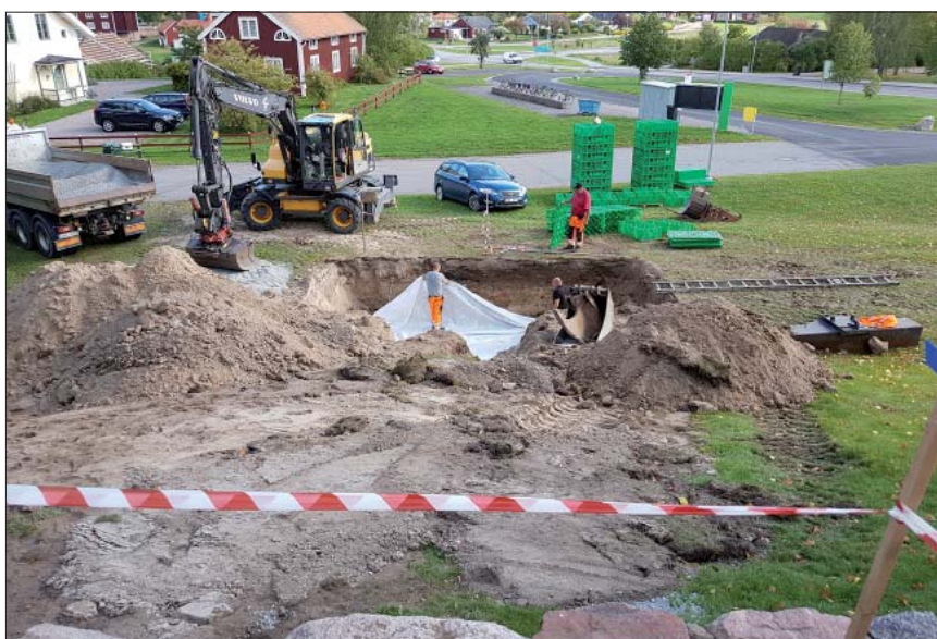
Figur 9. Arbetet pågår i gropen för fördröjningsmagasinet. Foto från östra bogårdsmuren. Foto Ann-Charlott Feldt, ÖM.
