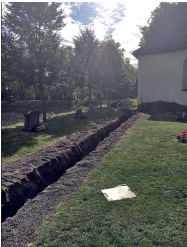
Figur 4. Schaktet i en av kyrkogårdens grusgångar. Foto från norr, Helén Romedahl, ÖM.
