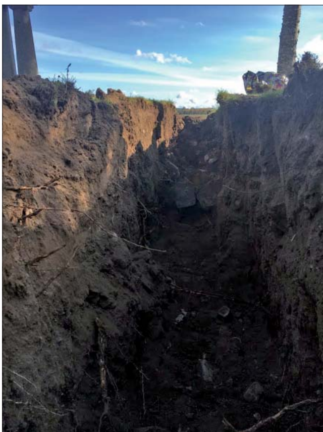
Figur 5. Schaktet inom vilket en del av gamla kyrkogårdsmuren syntes. Foto från öster, Helén Romedahl, ÖM.
