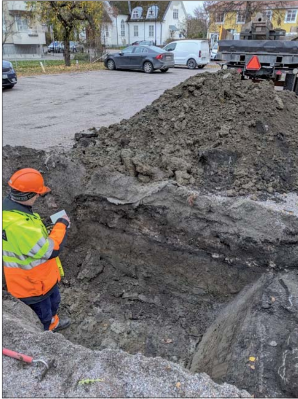
Figur 4. Schakt 1. Foto mot SO, Mats Magnusson, ÖM.
