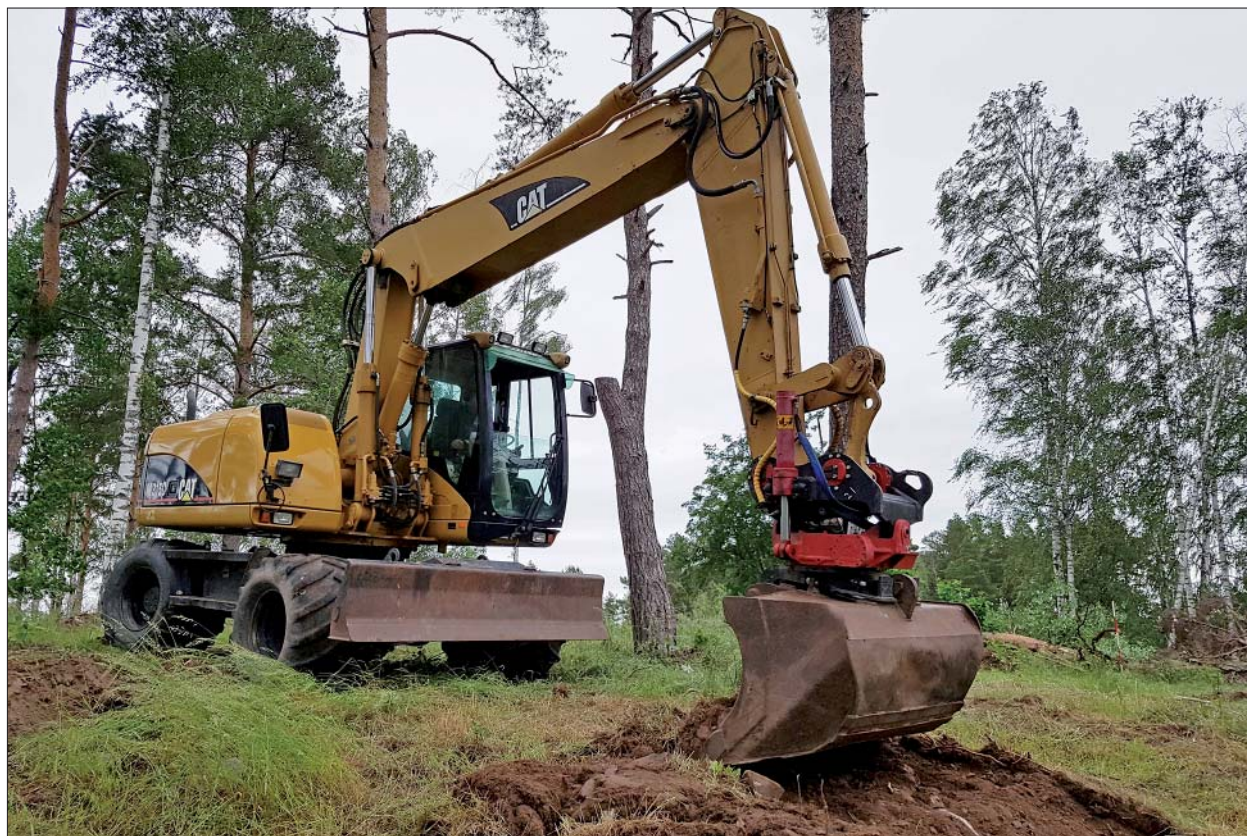
Figur 4. Schaktgrävning. Foto från SSV, Anders Olofsson, ÖM.
