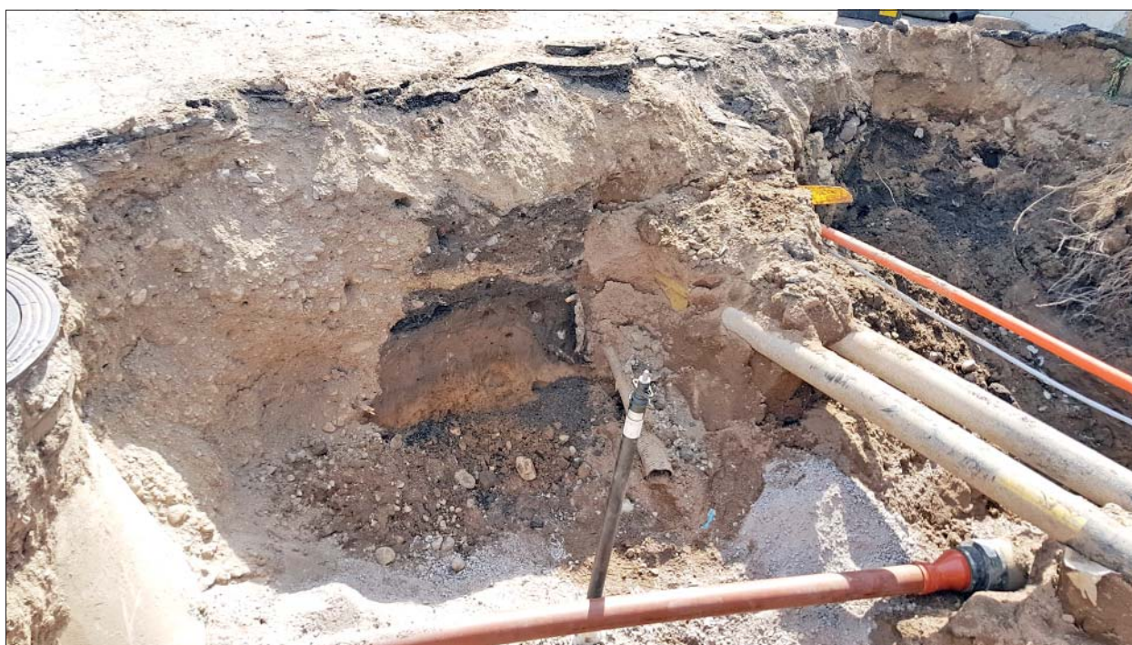
Figur 4. Schaktet sett från väster. Foto Ann-Charlott Feldt, ÖM.
