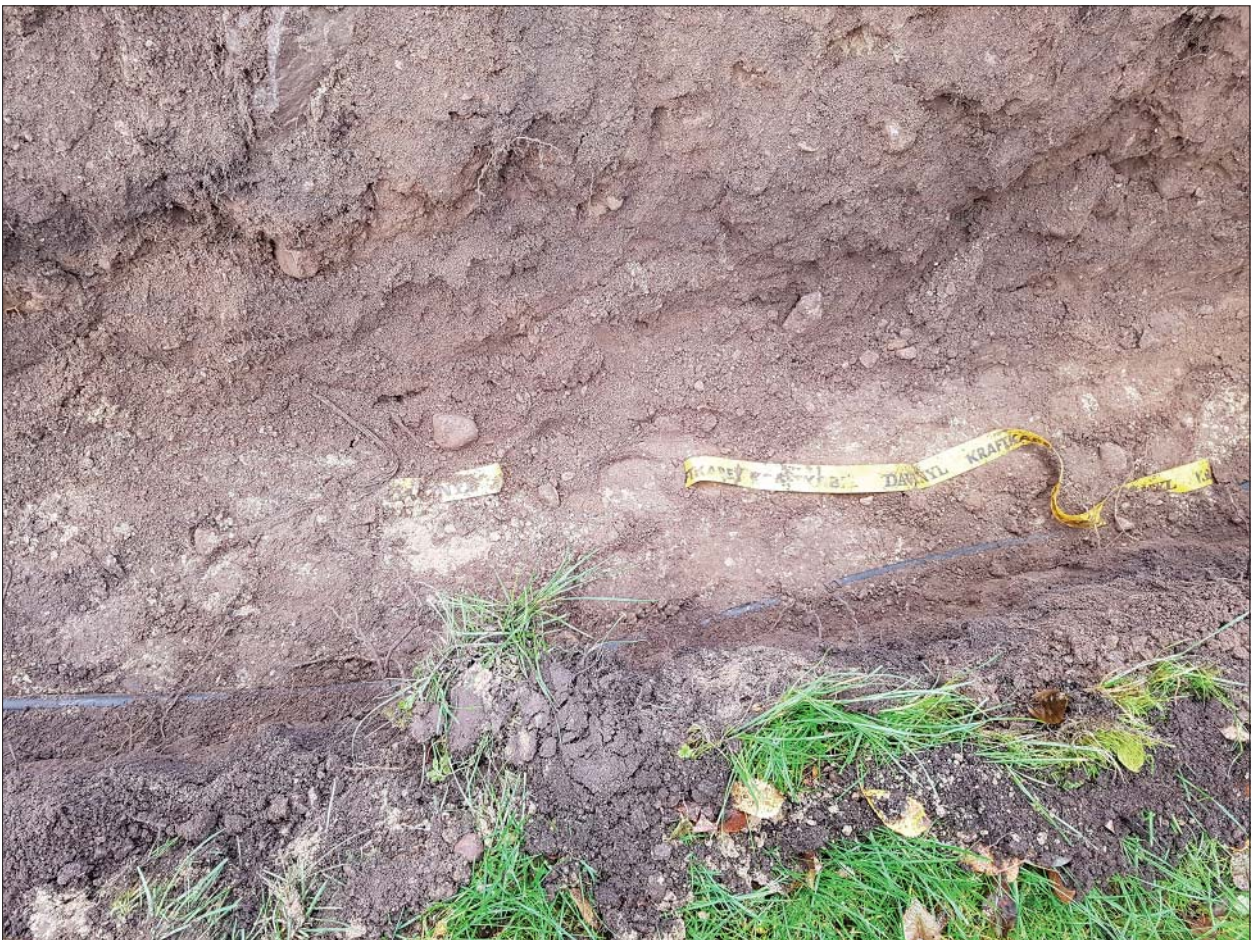
Figur 5. Kabeln drögs i ett tidigare schakt. Foto Anders Olofsson, ÖM.
