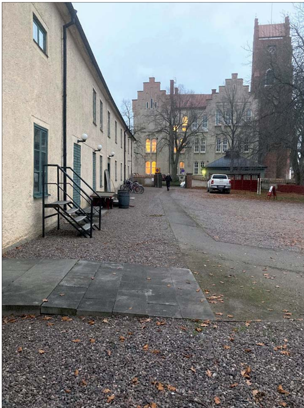
Figur 3. Undersökningsområdet innan schaktning. Foto från norr, Helén Romedahl, ÖM.
