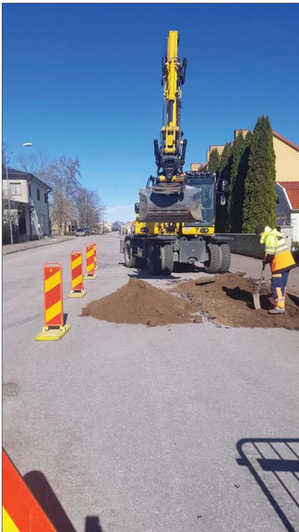
Figur 6. Schakt 628 togs upp i gatumark. Foto från söder, Helén Romedahl, ÖM.
