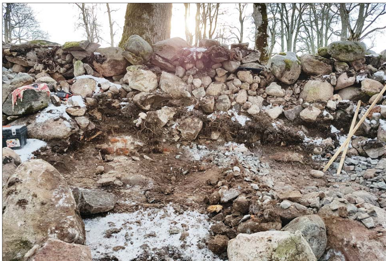
Figur 9. Tegelmurverk under bogårdsmuren i den östra delen av den kontrollerade sträckan sett från norr. Foto Ann-Charlott Feldt, ÖM.
