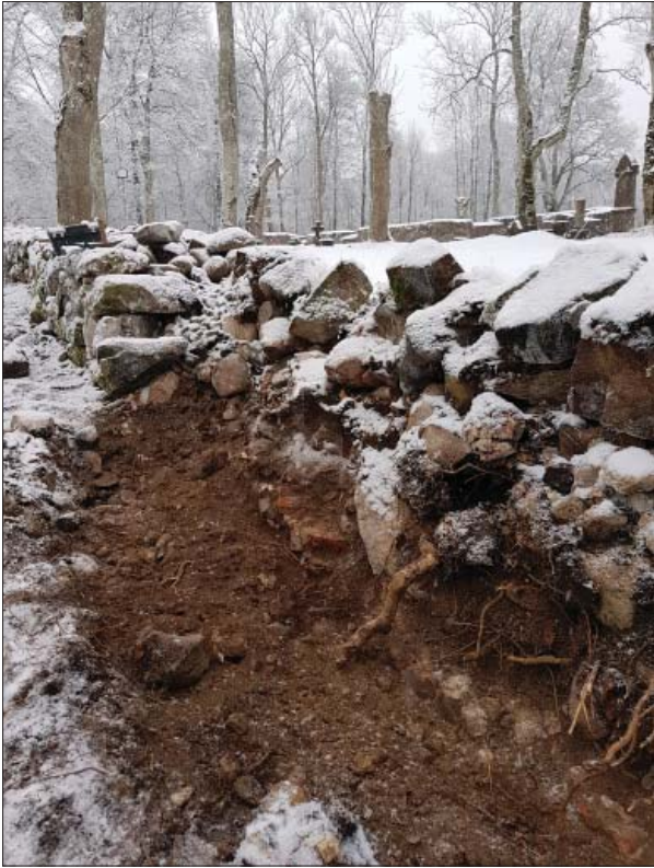
Figur 12. Tegel och kullerstenar lagda i kalkbruk under bogårdsmuren. Foto från väster, Ann-Charlott Feldt, ÖM.
