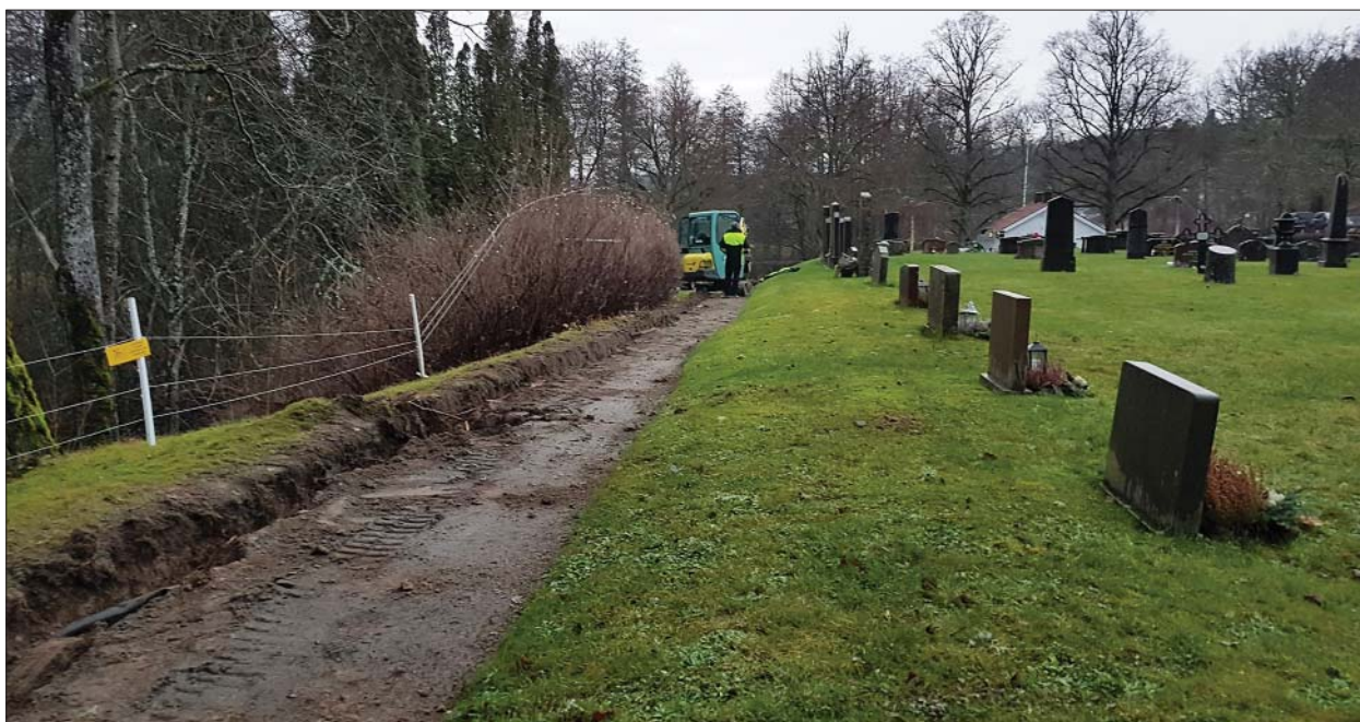
Figur 7. Det södra schaktet som grävdes i grusgången längs med bäckravinen. Foto från nordöst. Foto Ann-Charlott Feldt, Östergötlands museum.
