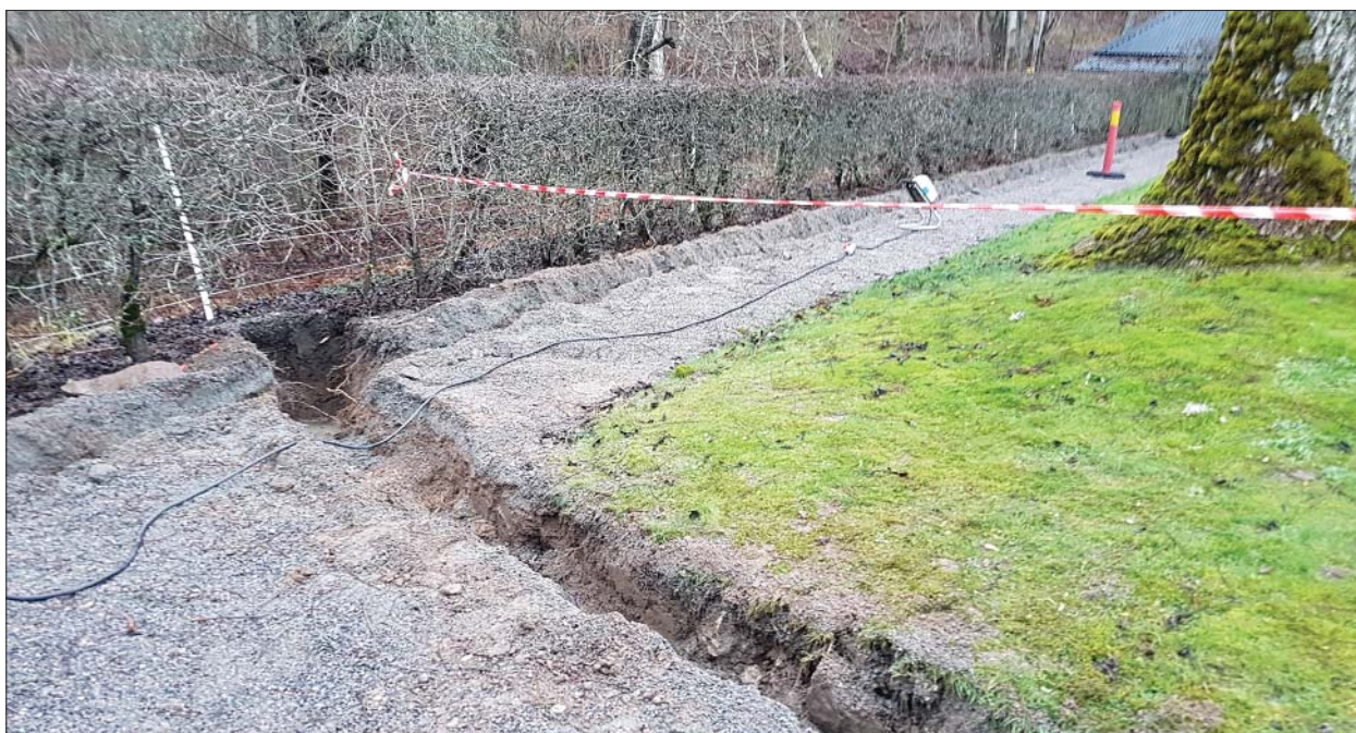
Figur 6. Schaktsträckningen längs östra sidan av kyrkogården och den östligaste delen av det schakt som löpte längs kyrkans sydvägg. Foto från väster. Foto Ann-Charlott Feldt, Östergötlands museum.
