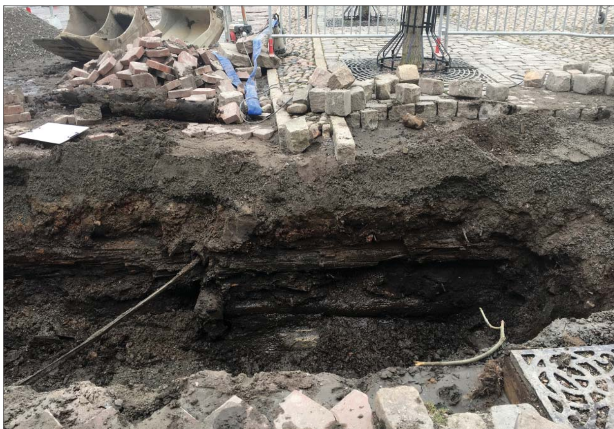
Figur 5. Detaljbild träkonstruktionen i norra schaktväggen. Foto mot norr, Helén Romedahl, ÖM.
