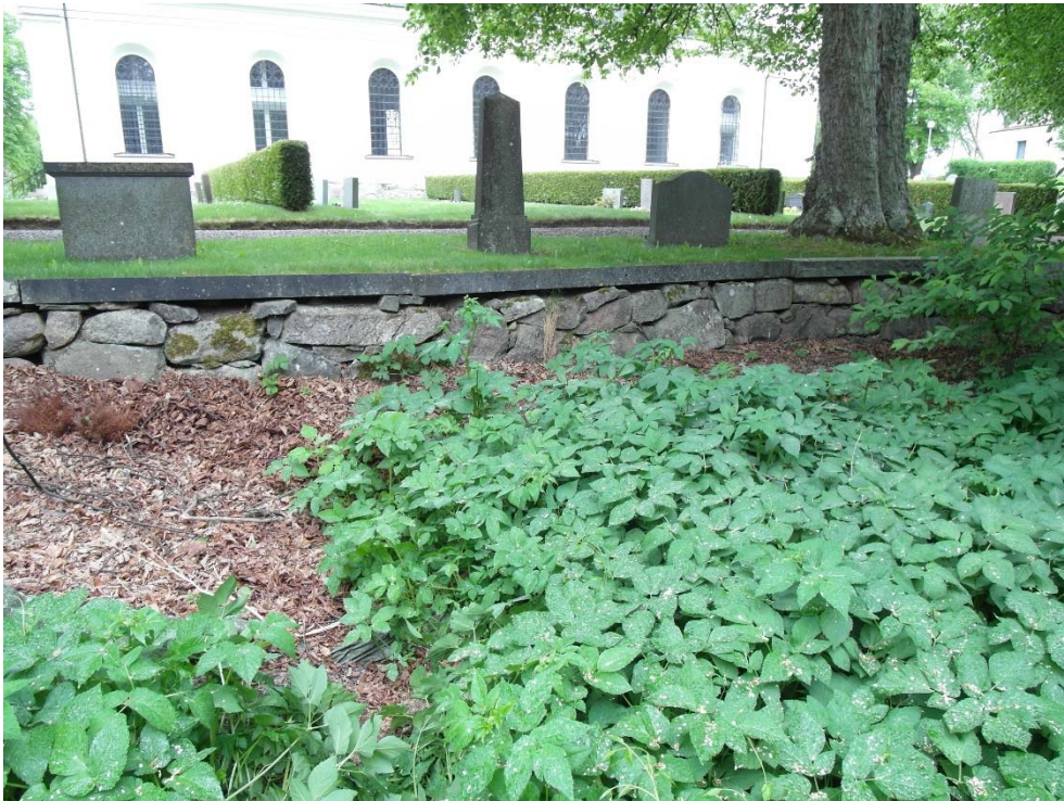
Förmultnande löv hade byggt upp ett tjockt lager framför muren.
