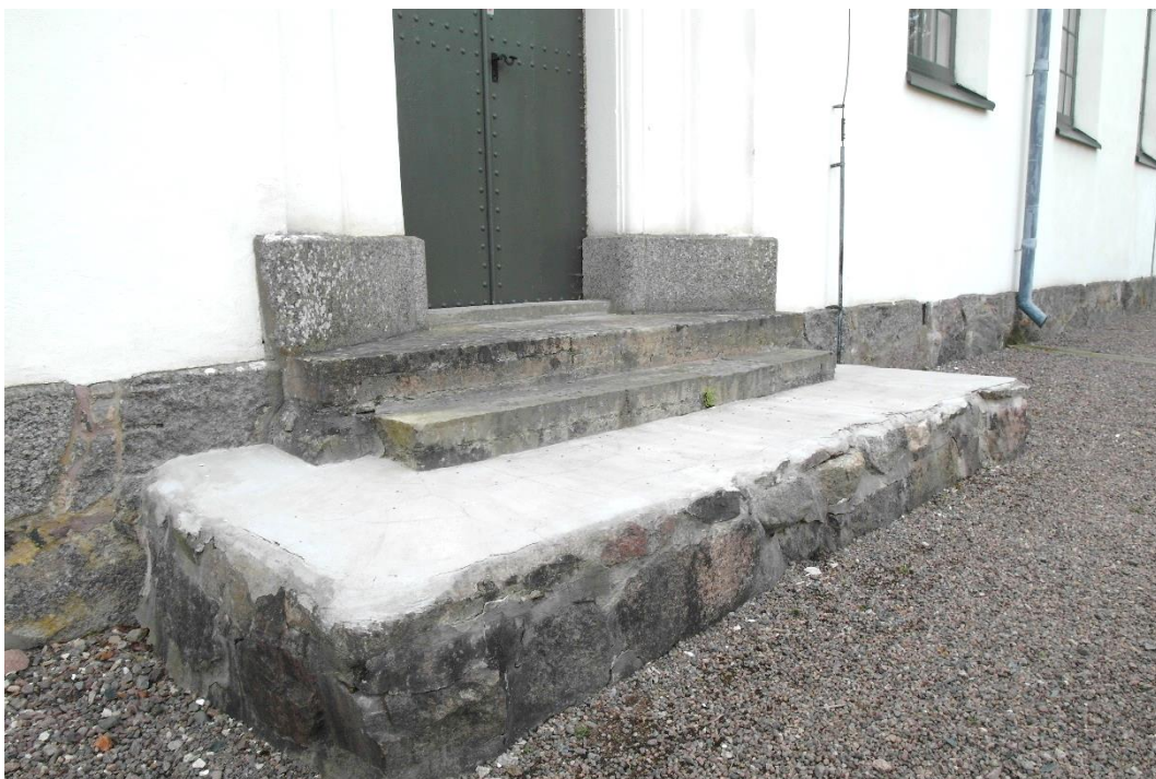
Norra trappan före omändring.
