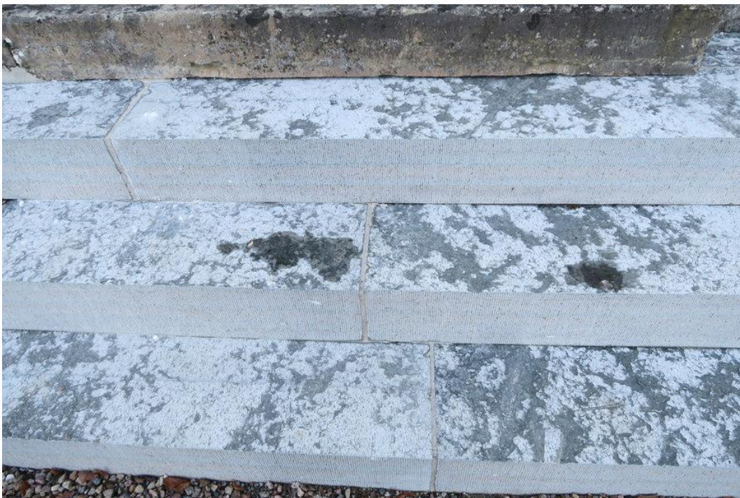
De nya trappstegen efter fogning. Lågerhuggen framsida i likhet med befintlig sten.
