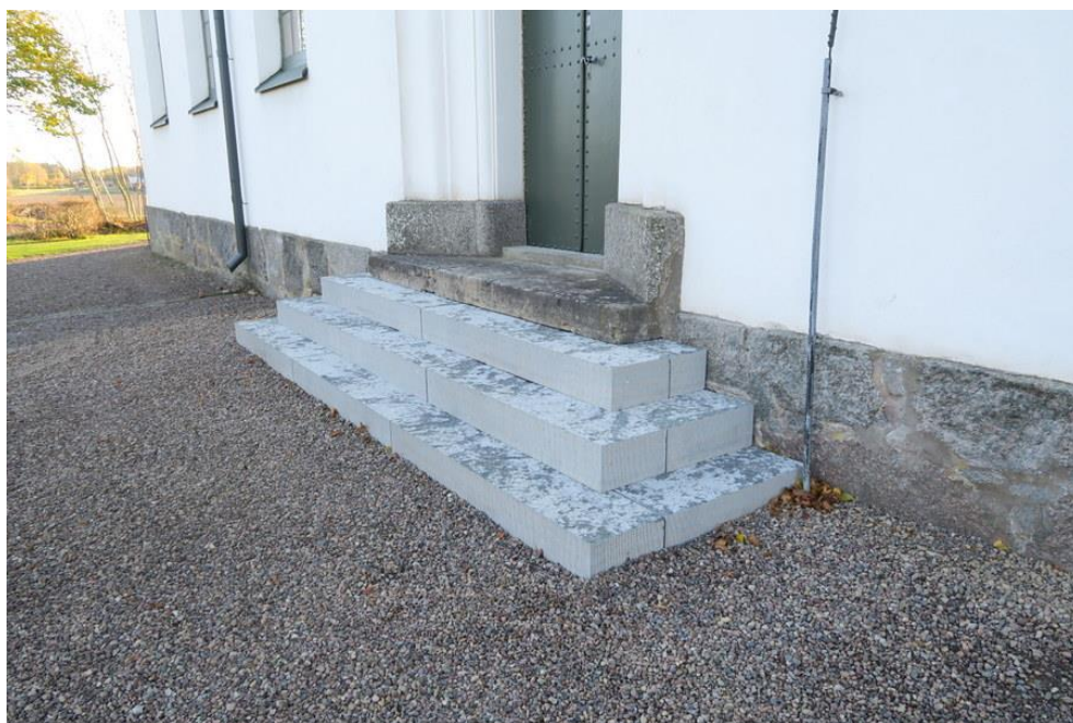
Norra trappan med nya steg, men innan fogning.
