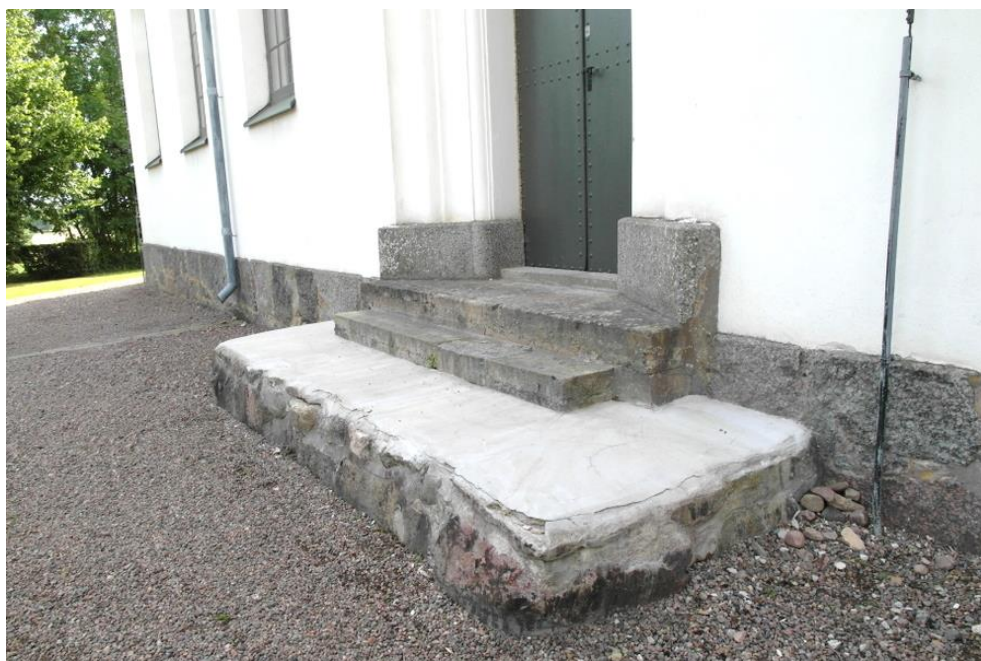
Norra trappan före omändring.
