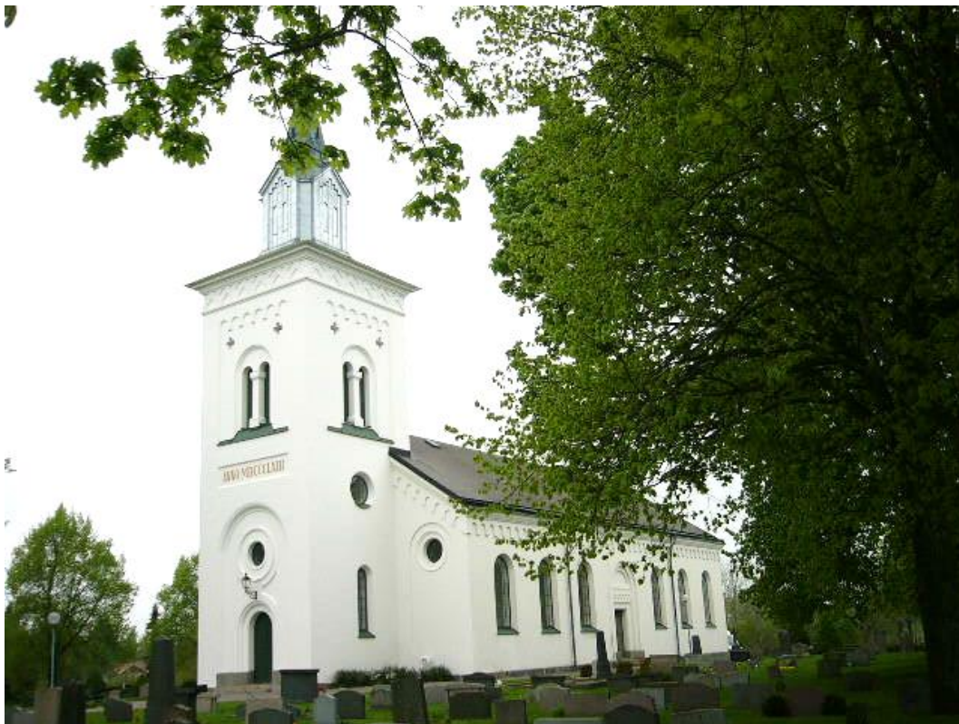
Gistad kyrka från sydväst. Foto Östergötlands museum 2005. Taket var då sedan 1970-talet täckt med eternitplattor. År 2015 lade man åter skifferplattor på taket.
