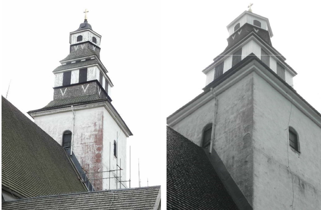
Tornets nordöstra hörn före och efter tvättning. Inga lagningar av putsen har gjorts.
