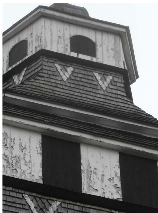
Underhållsbehovet för målning och tjärning var omfattande.
