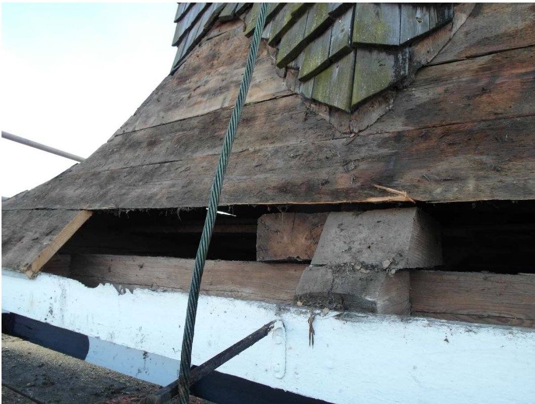
Delar av nedre brädan i lanterninens "kjol" byttes.
