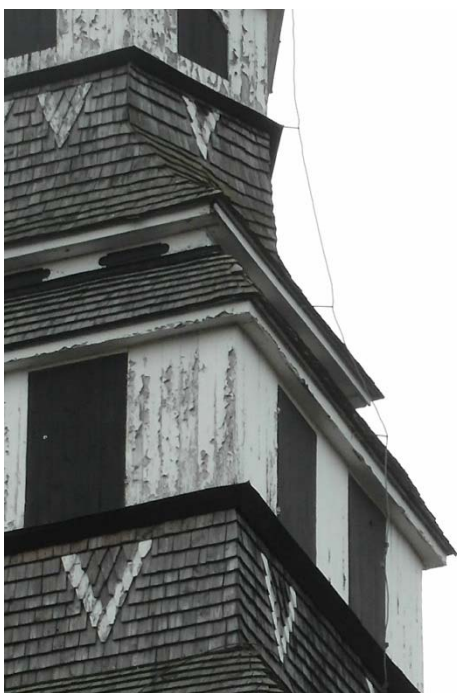
Underhållsbehovet för målning och tjärning var omfattande.
