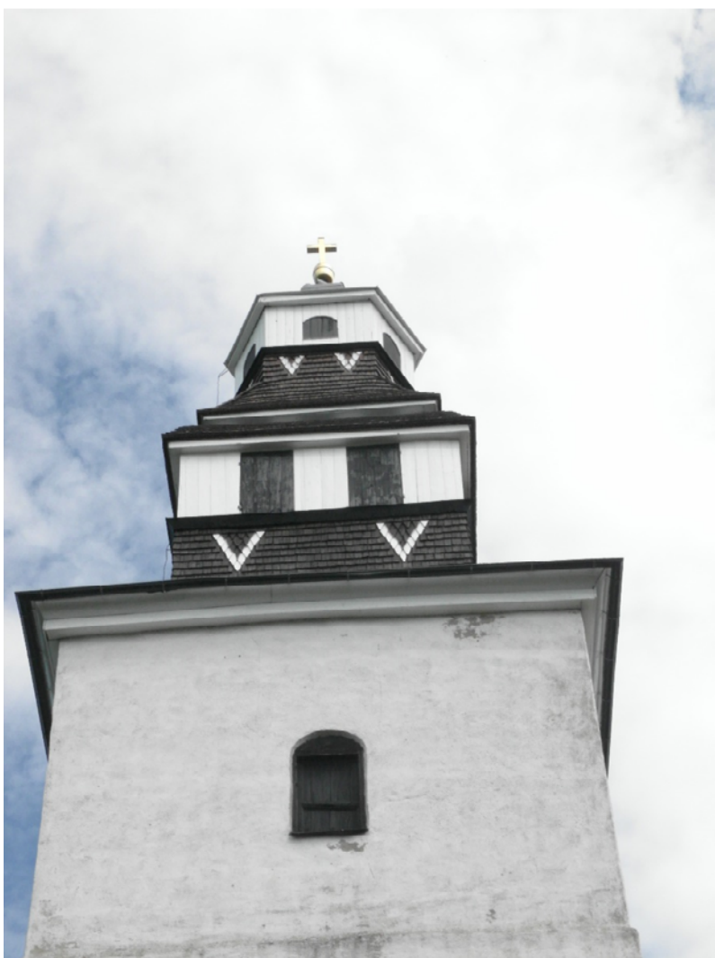
Tornets övre del efter renovering.
