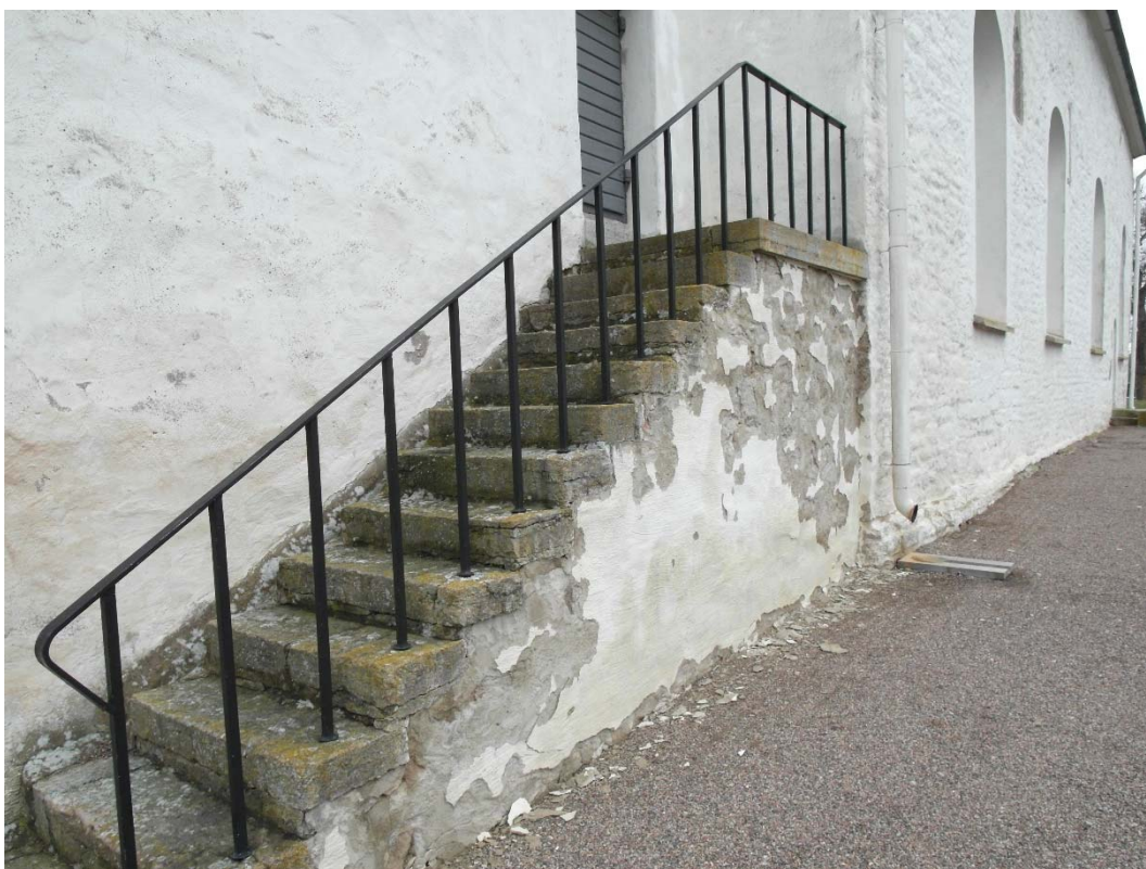
I söder finns en utvändig uppgång till tornet. I planeringen av den utvändiga tornreoveringen ingick omputsning av trappan. Ambitionen var att göra en mer omfattande reovering av tornets fasader, men det stannade vid rengöring och trappan åtgärdades inte vid detta tillfälle.
