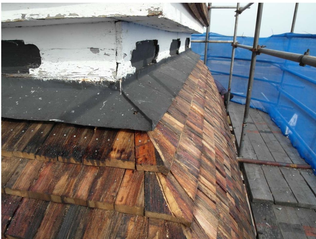
Ny spåntäckning på övre torntaket.
