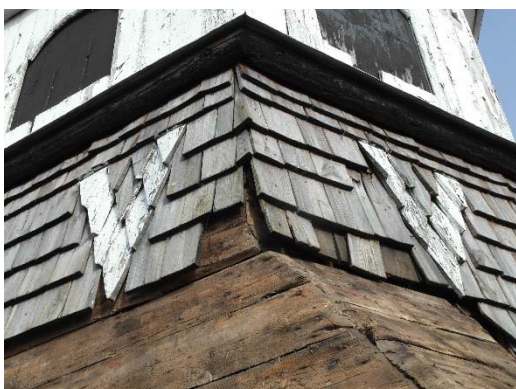
Ny spåntäckning lades liksom tidigare med den spetsformade dekoren.
