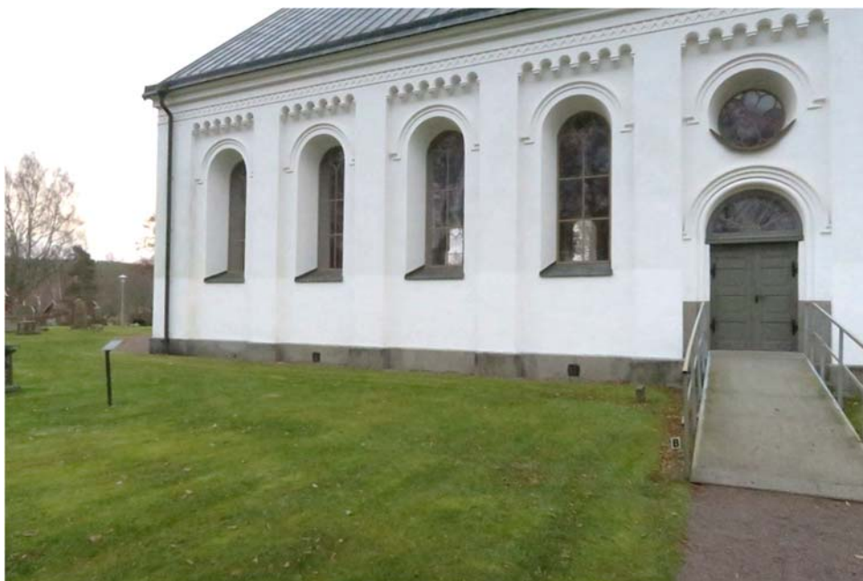
Norra fasaden efter putslagningar och avfärgning.
