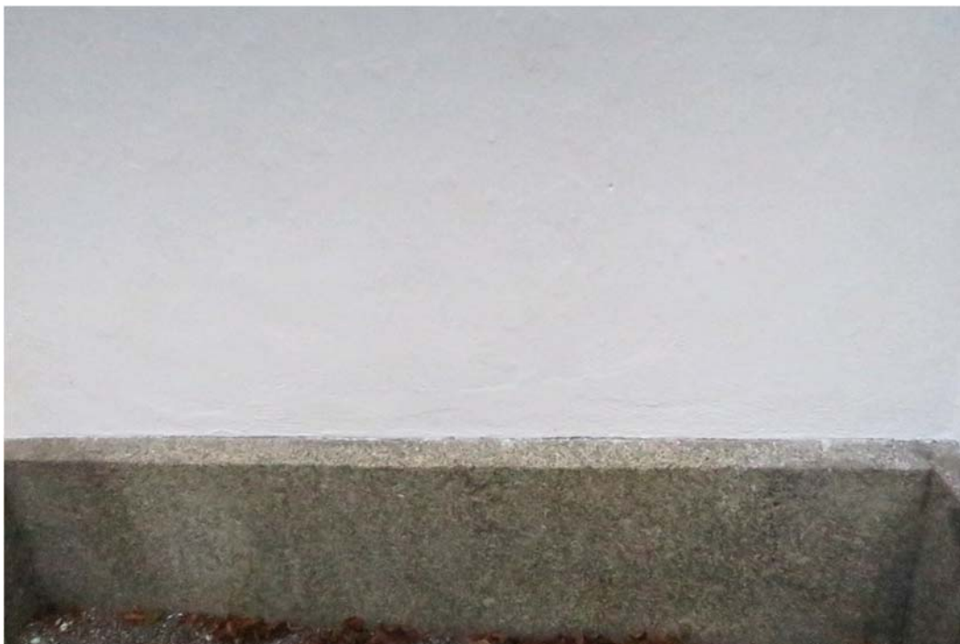
Detalj av putslagad fasad.
