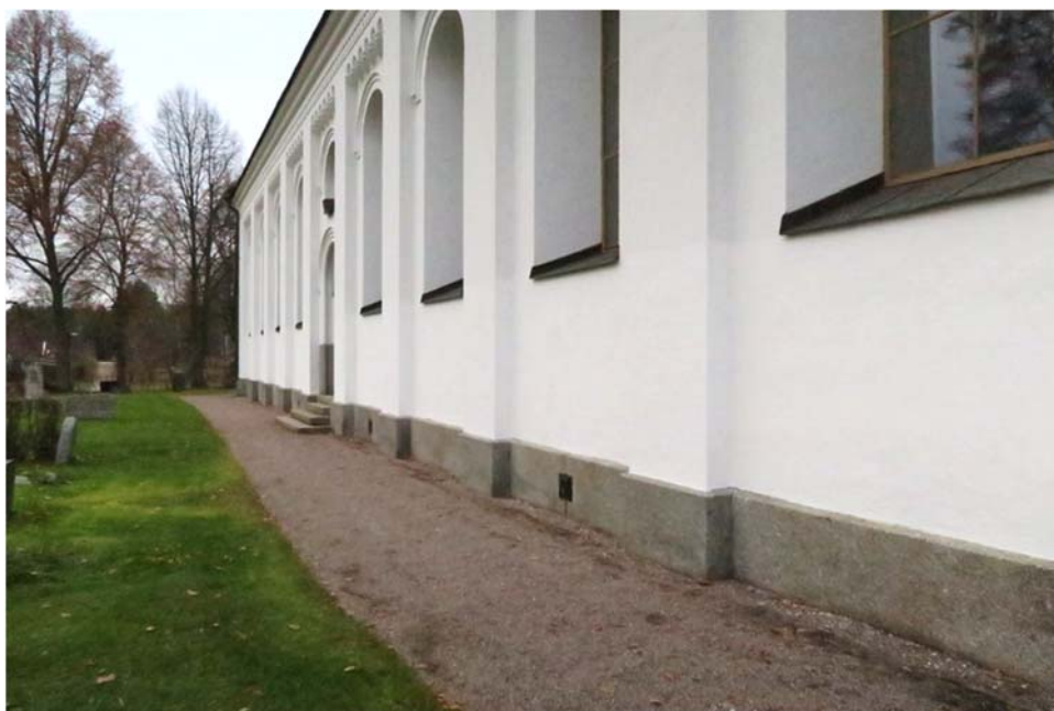
Södra fasaden efter putslagningar och avfärgning.
