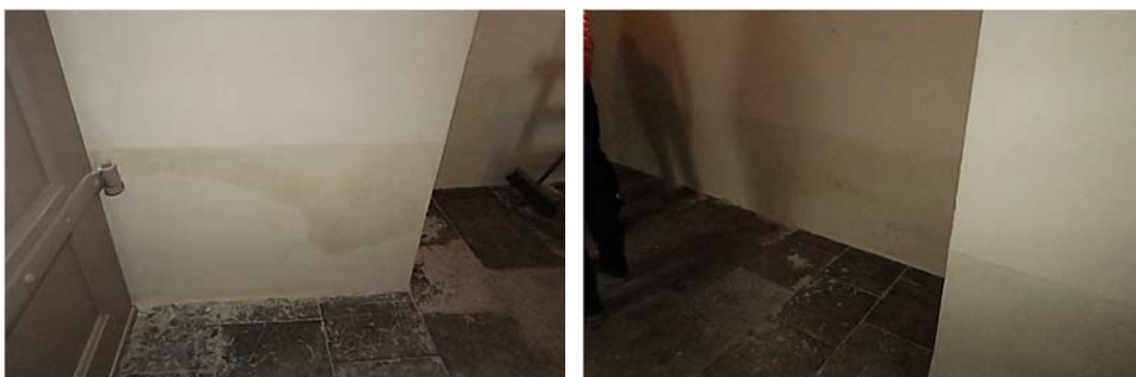
Lagning och avfärgning inne i vapenhuset.
