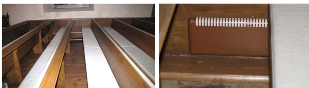
Ny radiator i bänkkvarter. Troligen gör fotoblixten att radiatorns vita insida framträder så tydligt. Intrycket var inte detsamma på plats.
