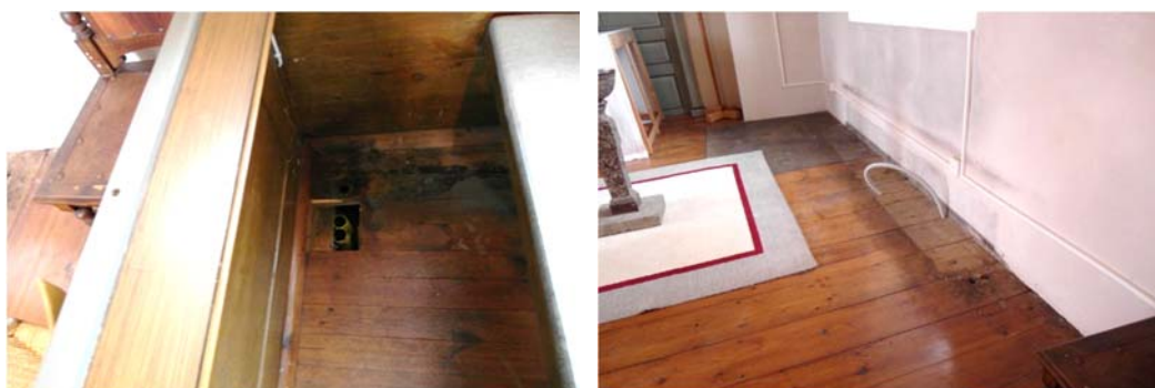
T v: I norr och söder kommer rören till radiatorerna upp i de främre bänkraderna. T h: Dragnig är gjord för ny radiator vid korets södra vägg.
