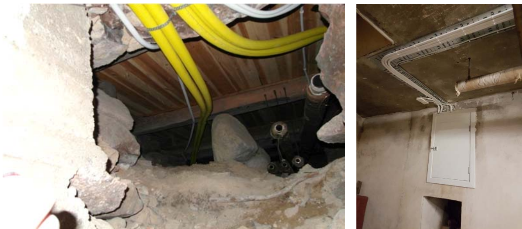
T v: Ledningsdragningar gjordes från pannrummet in under kyrkans golv. T h: De nya installationerna är färdiga och öppningen in till kyrkogrunden stängs med en brandsäker lucka.
