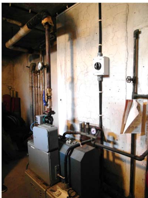
Pannrummets västra vägg. Rören längst bort på bilden till vänster går genom en igensatt öppning in i kyrkans grund. Bilderna är tagna före utbytet av värmesystem.
