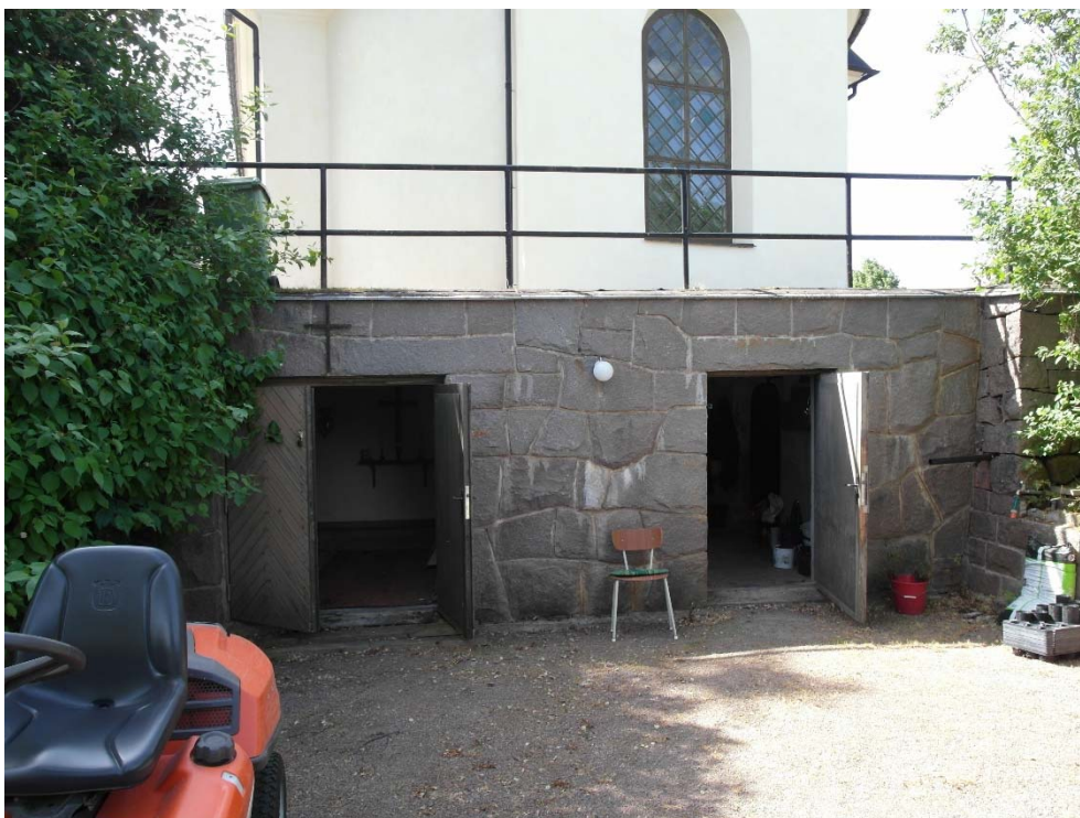
Pannrummet ligger under sakristian och ingången till pannrummet är via dörren till höger i bild. Man kan även nå pannrummet genom en öppning i sakristiegolvet. Pardörren leder till ett bisättningsrum.
