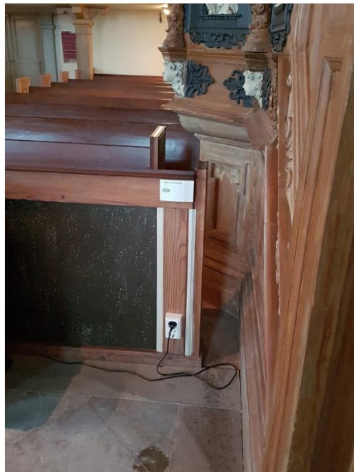
Repeater i predikstolen och givare för bänkvärmare på främre bänkskärmen i norr.
