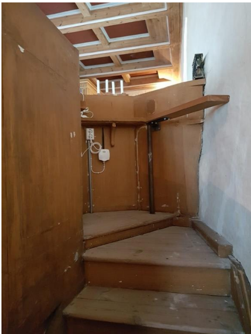
Repeater i predikstolen och givare för bänkvärmare på främre bänkskärmen i norr.
