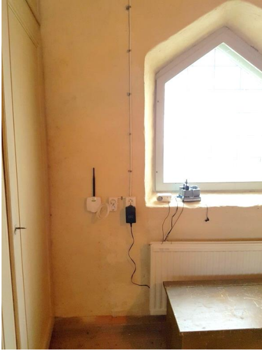
Sakristian. T v: Repeatern (med antenn) behöver kopplas till elnätet. T h: Givaren placerade i anslutning till befintlig strömbrytare.
