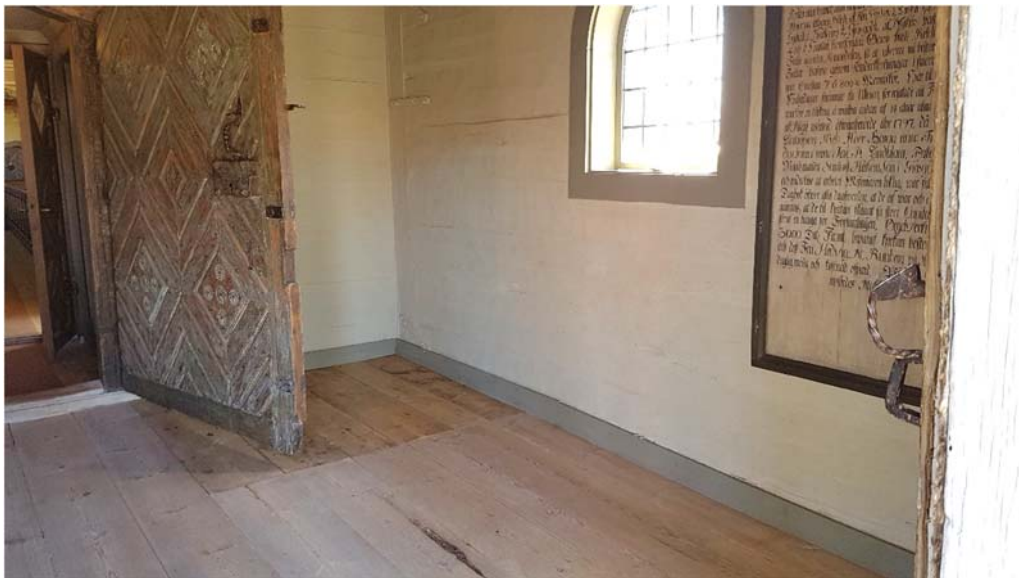
Sydvästra hörnet efter lagning. Golvbrädorna har återlagts så att den ilagade delen hamnar bakom dörren in till vindfånget.
