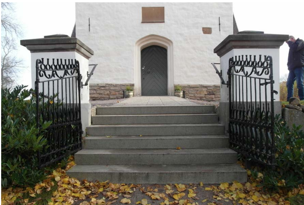
Västra ingången. Trappan och plattorna i gången till kyrkporten har justerats och ledstängerna har höjts. Putslagning återstår.
