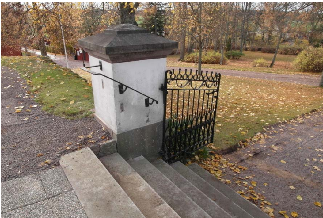
Västra ingången, södra grindstolpen. Trappstegen har justerats och ledstången har höjts. Putslagning återstår.
