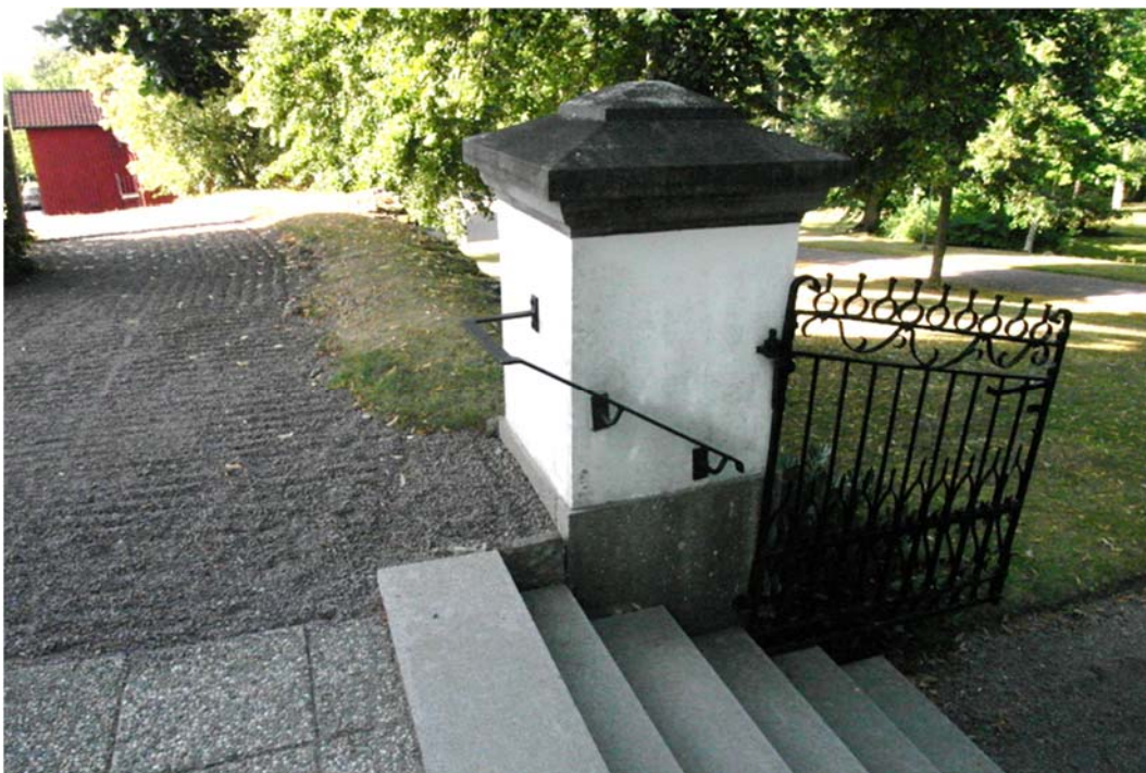
Västra ingången, södra grindstolpen. Före åtgärder.
