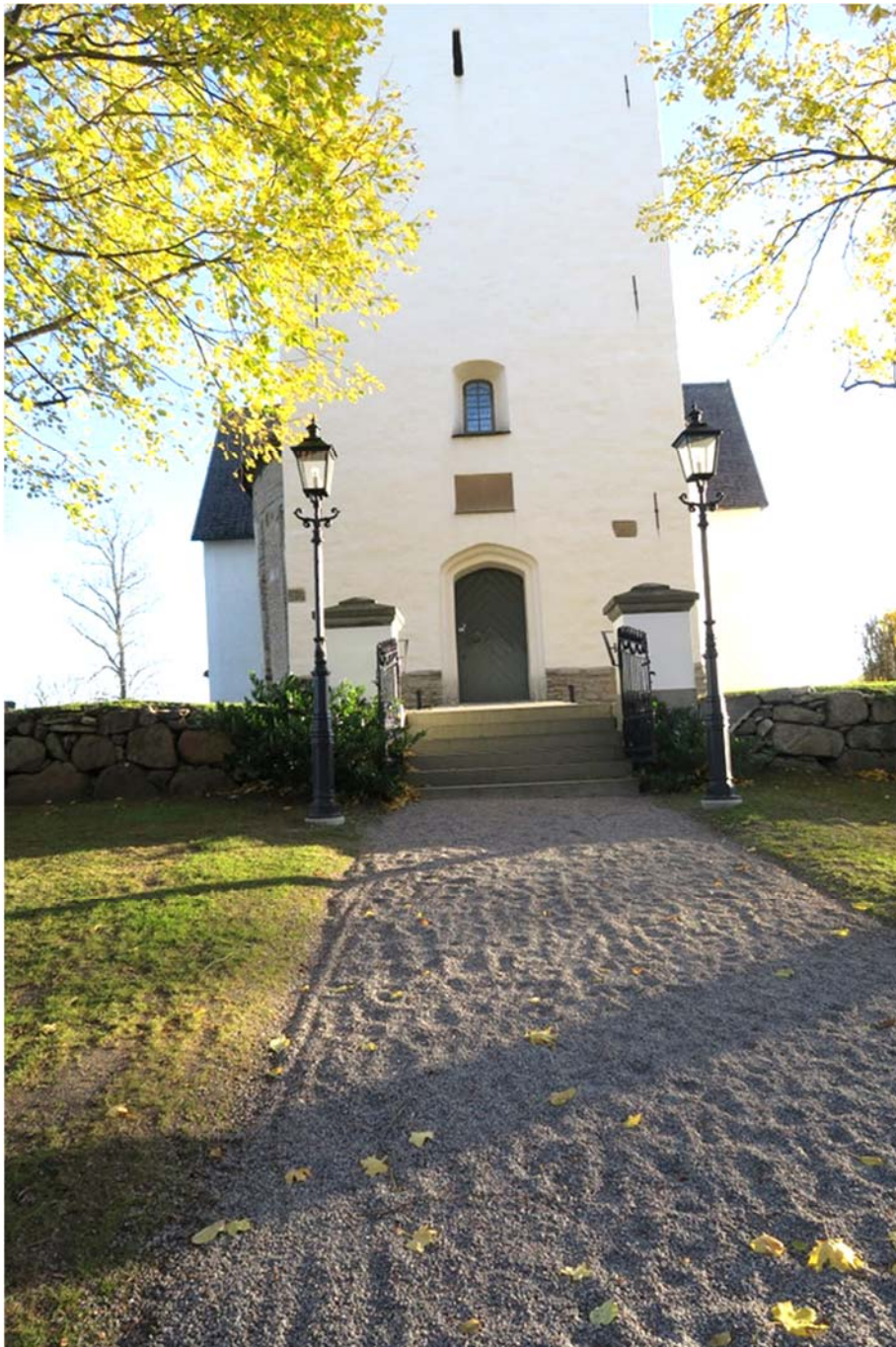
Västingången efter färdigställande.
