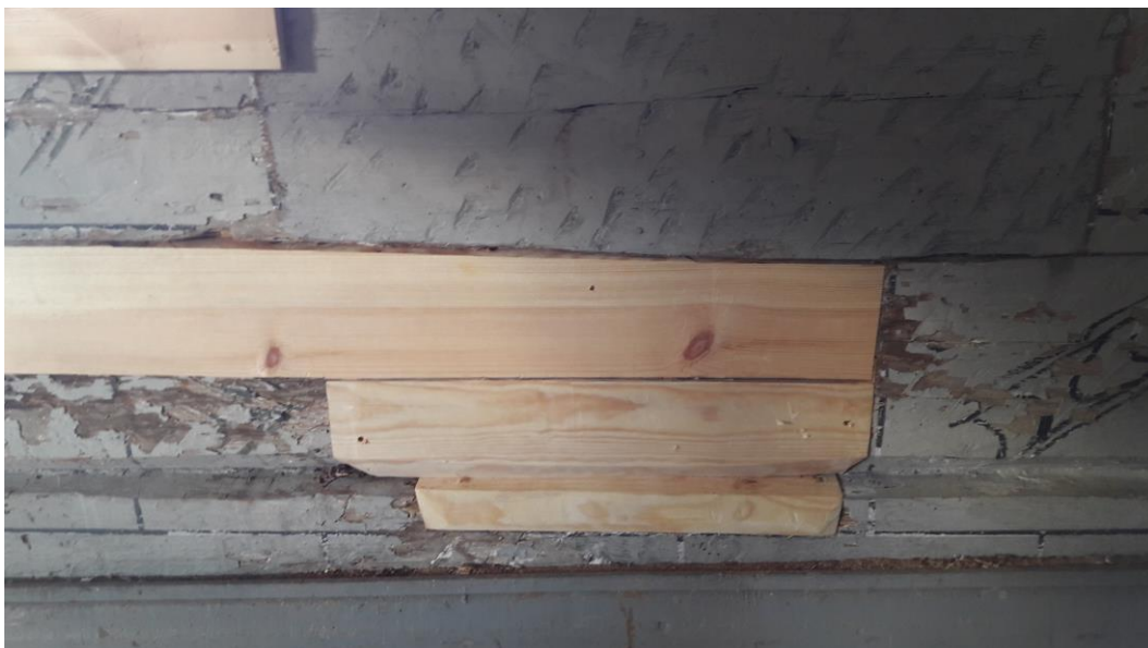
Grå stugan efter åtgärder: Ilagning interiört. Det skadade bemålade träet demonterades och sparas tills vidare.
