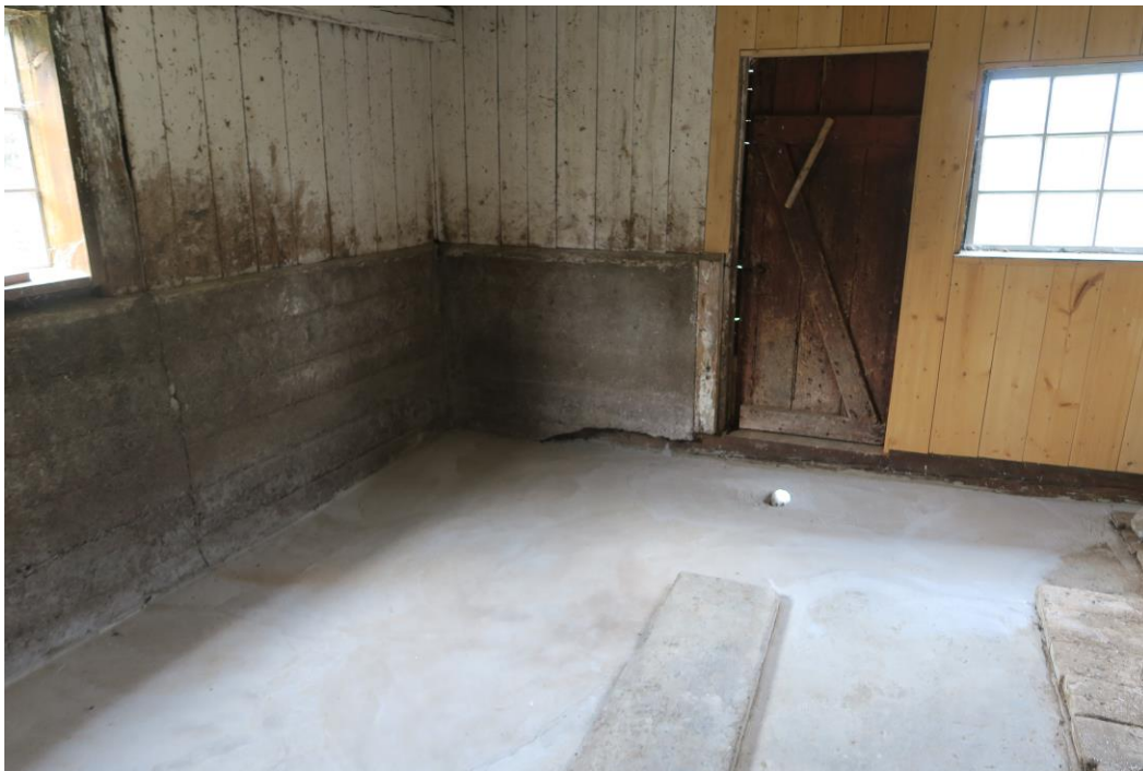
Röda ladugården efter åtgärder: betonggolvet är nygjutet och avrinningshål tillkommit.
