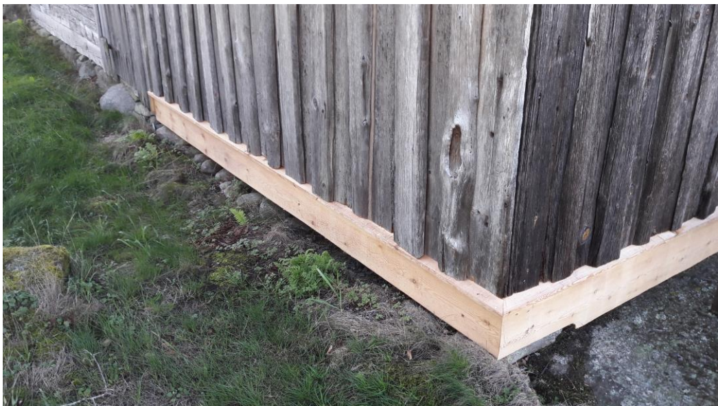
Grå ladugården efter åtgärder: Detalj på ilagning med liggande bräda och vattbräda.
