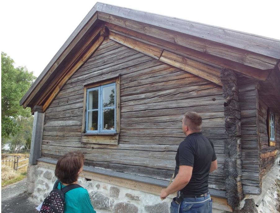
Grå stugan före åtgärder. Västra fasaden som ska panelas.
