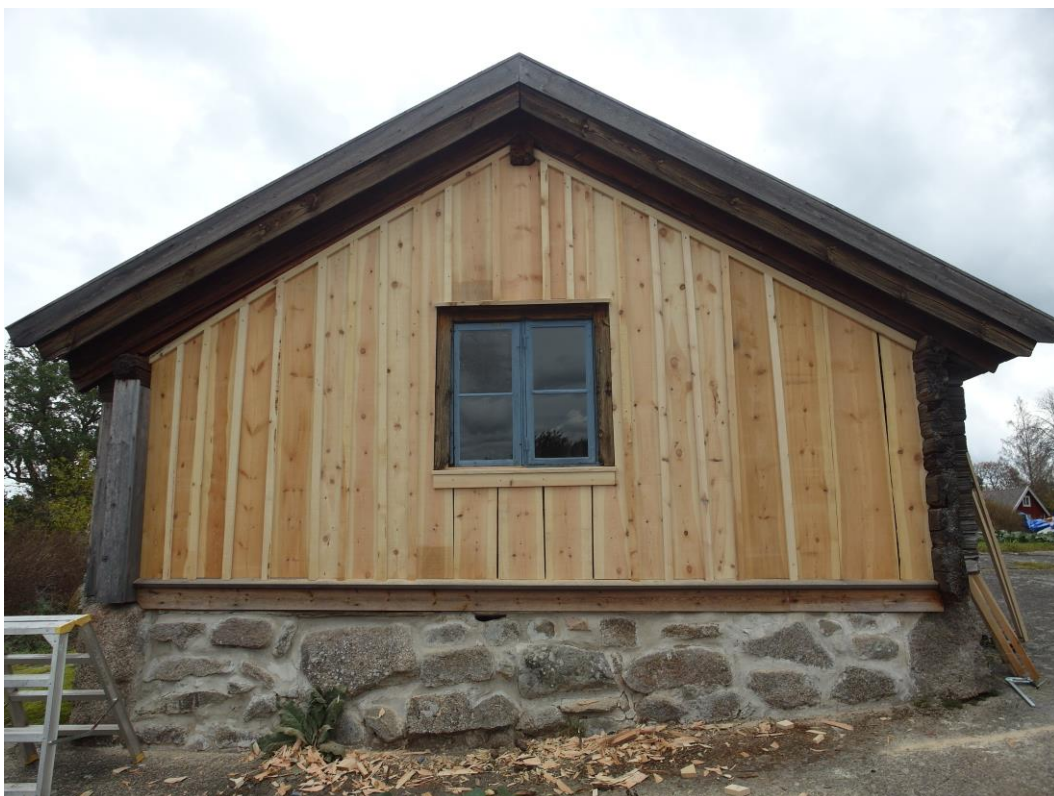
Grå stugan efter åtgärder: Västra fasaden med den nya panelen.
