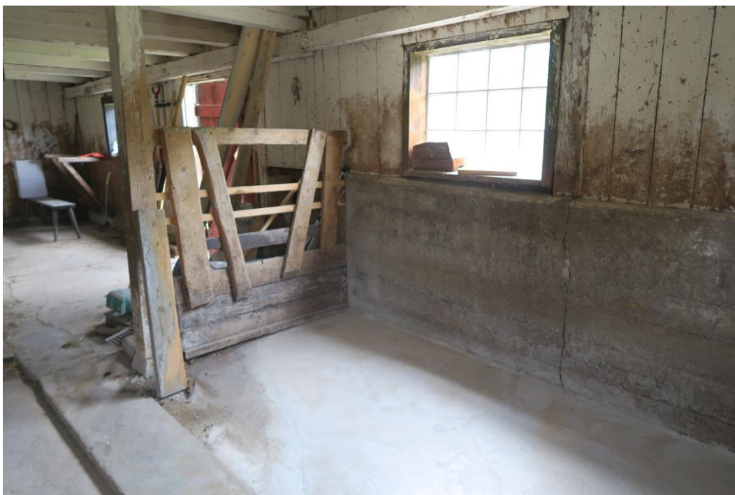
Röda ladugården efter åtgärder: betonggolvet nygjutet.
