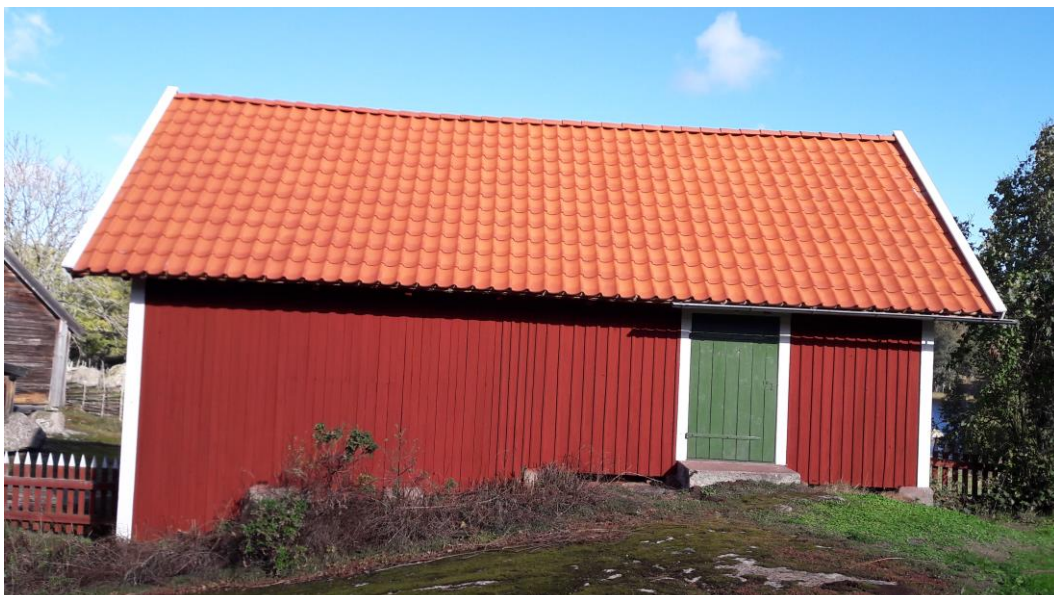
Röda boden efter åtgärder. Fasader, snickerier och ytterdörr målade.
