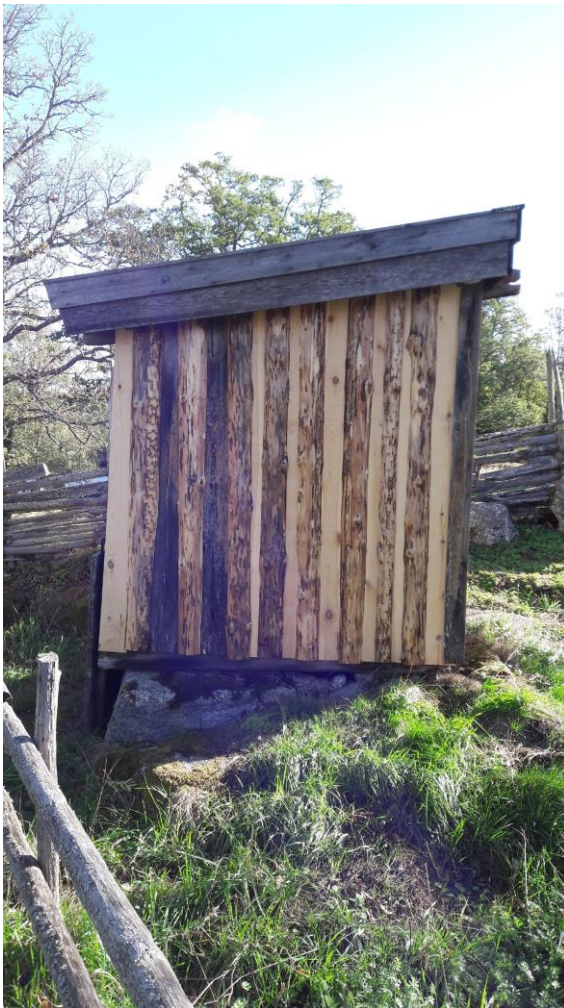
Grå dasset efter åtgärder: Västra fasaden med ny panel.
