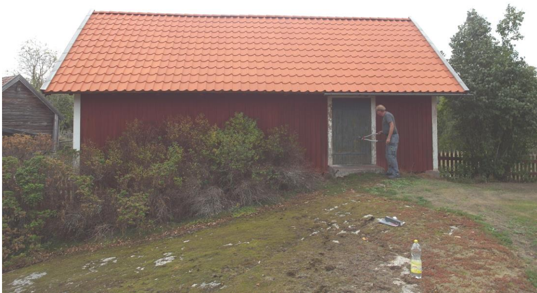
Röda boden innan åtgärder. Färgskrapning och fasadborstning påbörjad.
