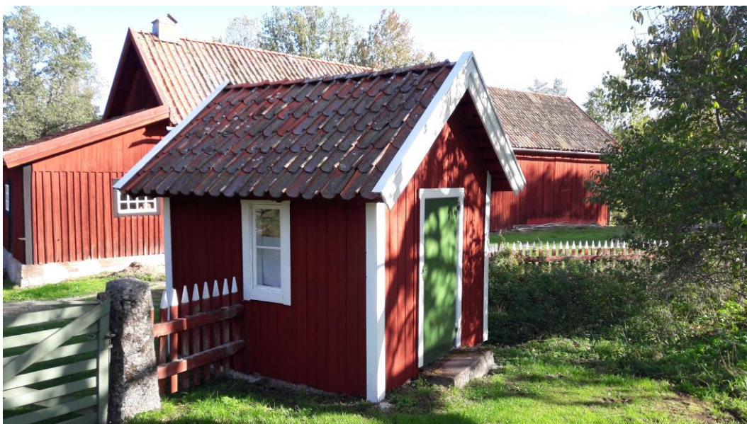
Röda dasset efter åtgärder. Fasader, snickerier och ytterdörr målade.
