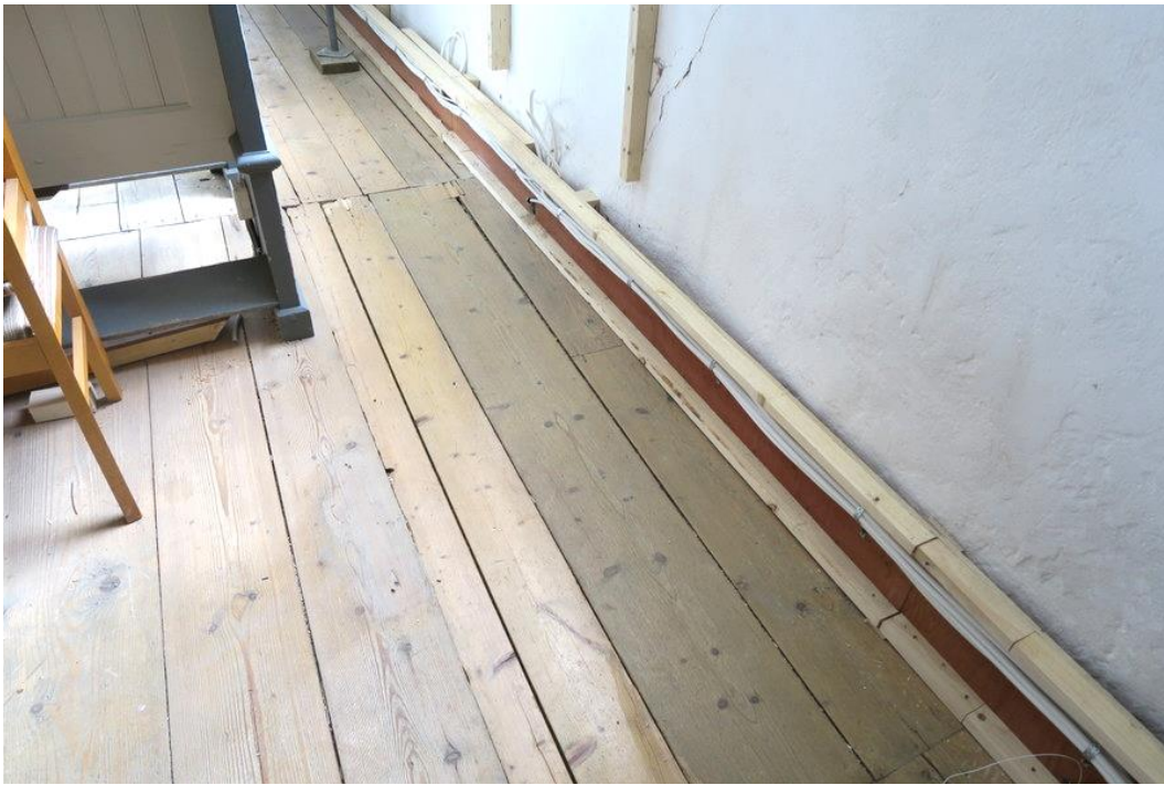
Kablar har lagts i stommen till det som ska bli golvsockel.
