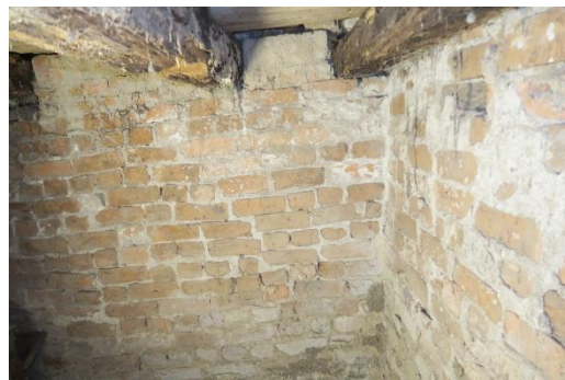
T v: Det var när man öppnade upp golvet i mittgången som man påträffade nergången till gravkoret. T h: Gravkoret är uppmurat av tegel.
