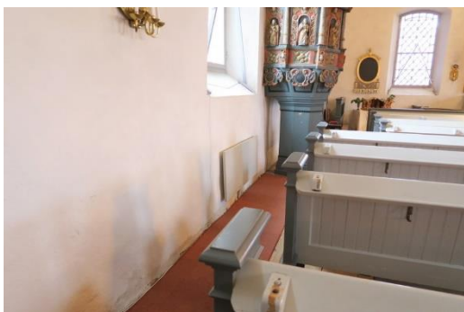
Kyrkorummet med de äldre radiatorerna.
