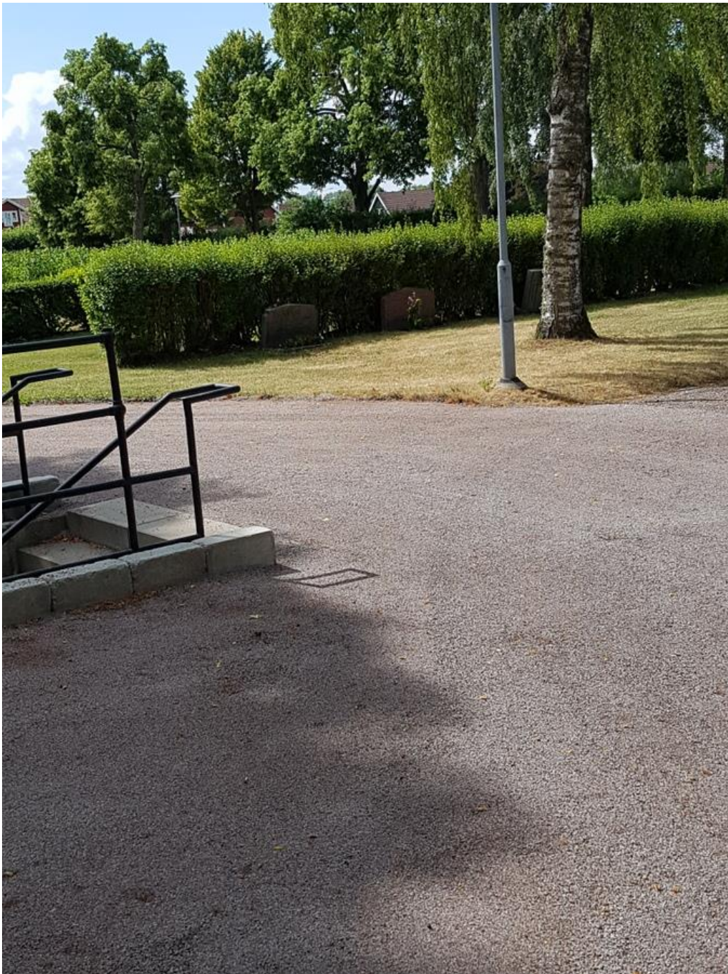
Marken vid trappan byggdes upp något innan den nya beläggningsen fördes på.
