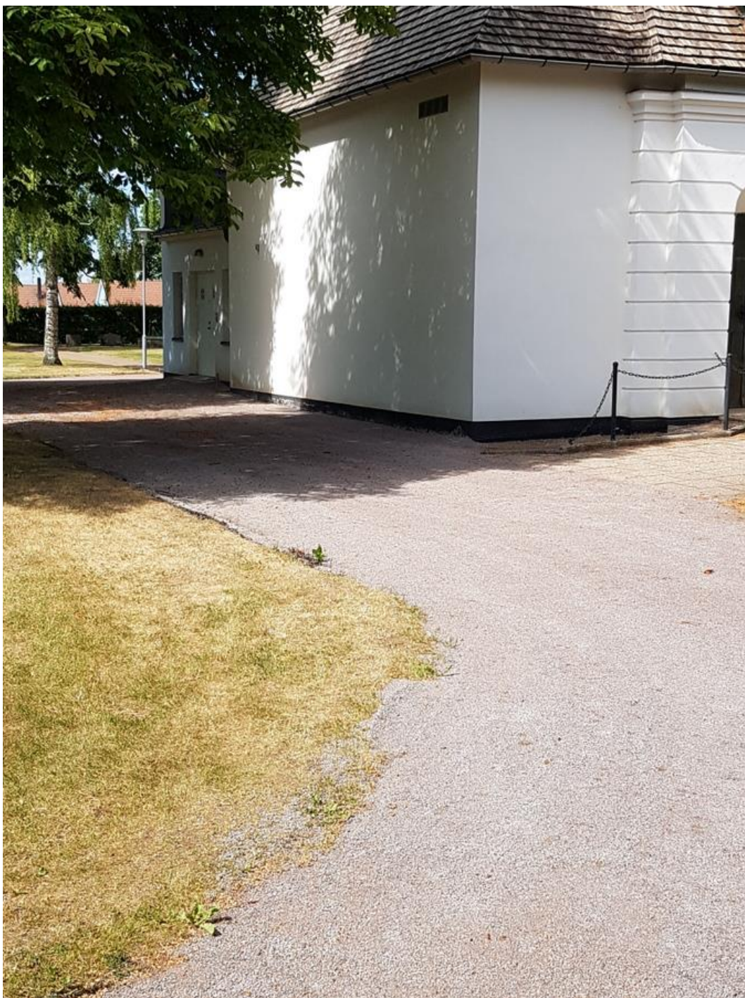
Beläggningen har utförts på huvudgången från ekonomibyggnaderna i väster fram mot gravkapellet och runt hela kapellet.
