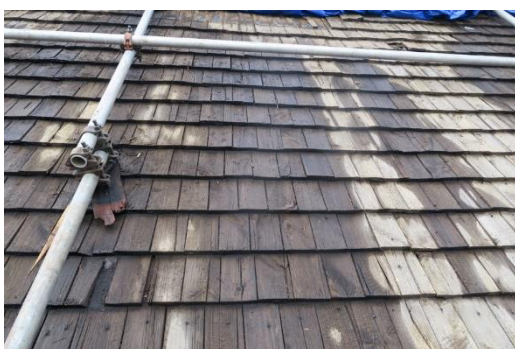
Befintligt spån på södra takfallet.
