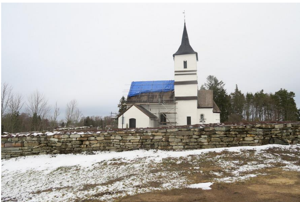
Arbetet har påbörjats.
