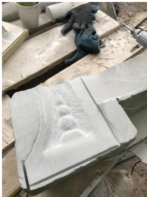
Bortfallen detalj och nytillverkning av motsvarande detalj. Foto Stefan Gullberg.
