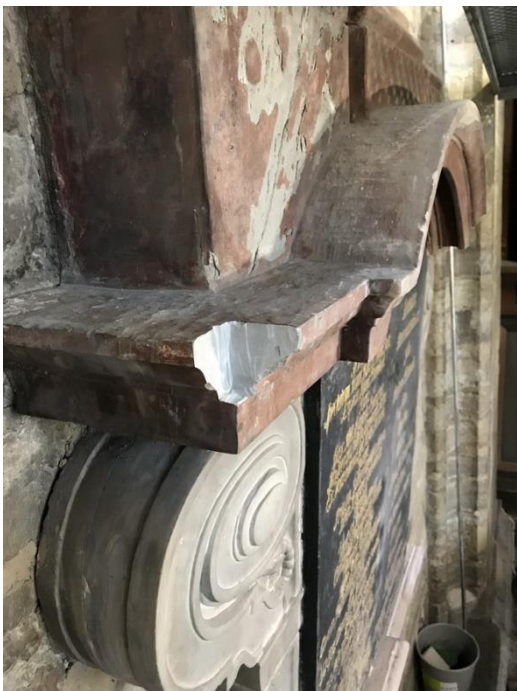
Större bortfallna delar ersattes med nyhuggna delar. Foto Stefan Gullberg.
