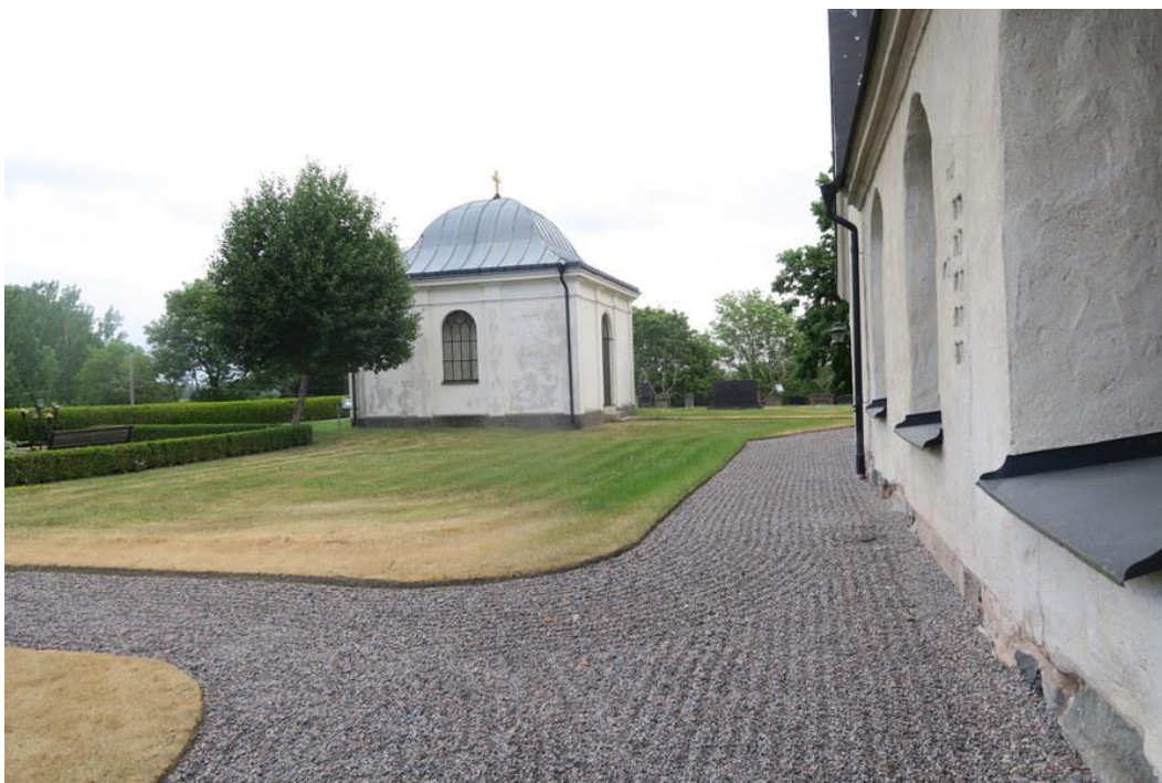
Gravkapellet från väster. Till höger i bild syns kyrkans nordfasad.
