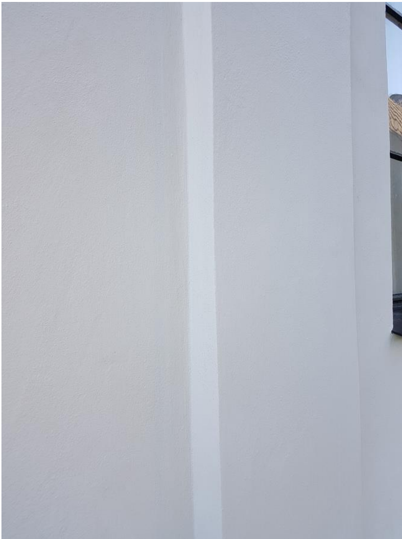
Detalj av färdigputsad och avfärgad fasad.
