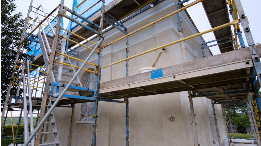
Avfärgning har påbörjats. Foto Åby Fasad AB.
