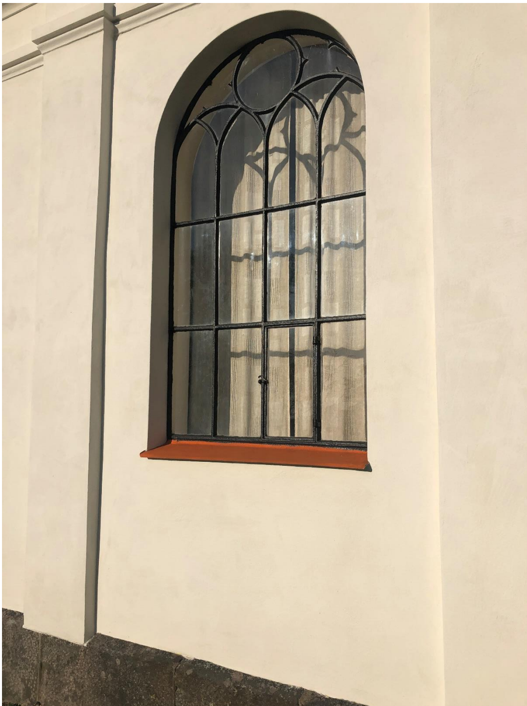
Fönsterblecket har strukits med blymönja. Bilden visar även de avfärgade fasaderna. Foto Åby Fasad AB.
