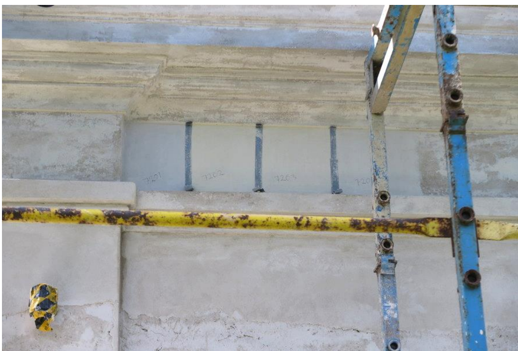
Fyra färgprover ströks upp. Numreringen av proverna utgår inte från Målarkalks kulörnumrering. Det beslutades att använda kulörprov 7204, det högra provet bakom byggnadsställningen.
