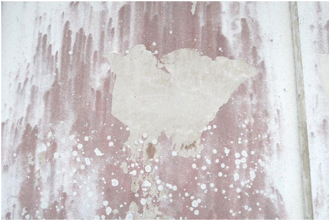
Algpåväxt och släpp i ytskiktet.
