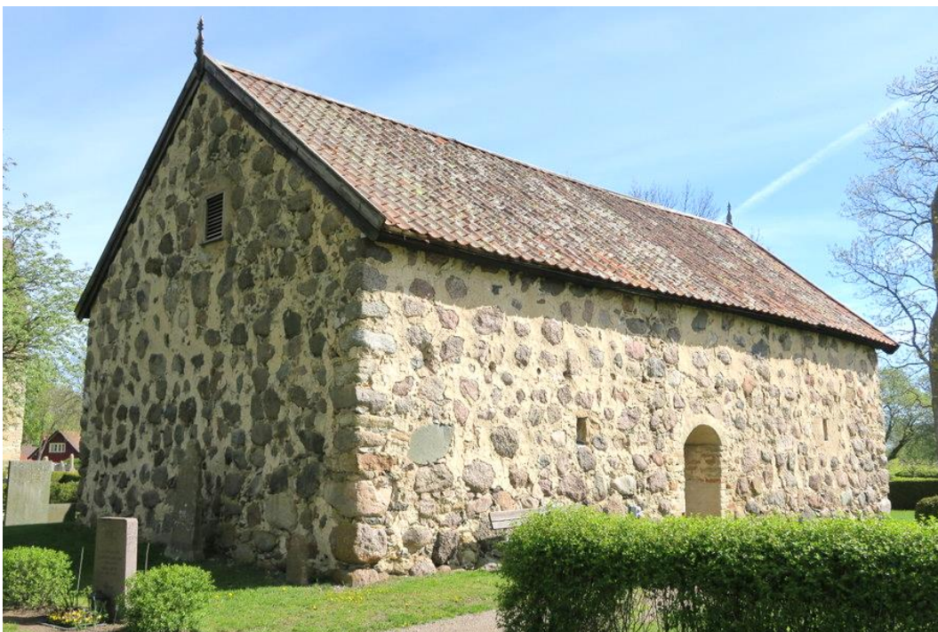
Bisättningshuset från sydväst före takomläggning.
