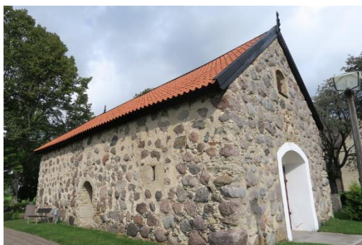
Från sydöst efter takomläggning.
