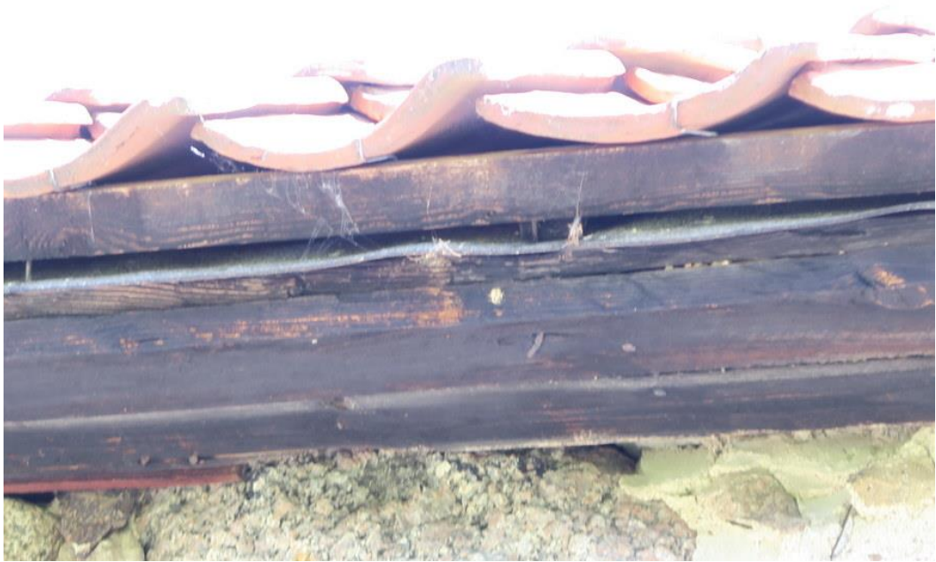
I takfoten stack takpappen från 1970-talet fram. Före takomläggning.
