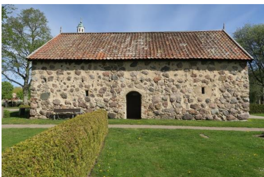
Från söder före takomläggning.
