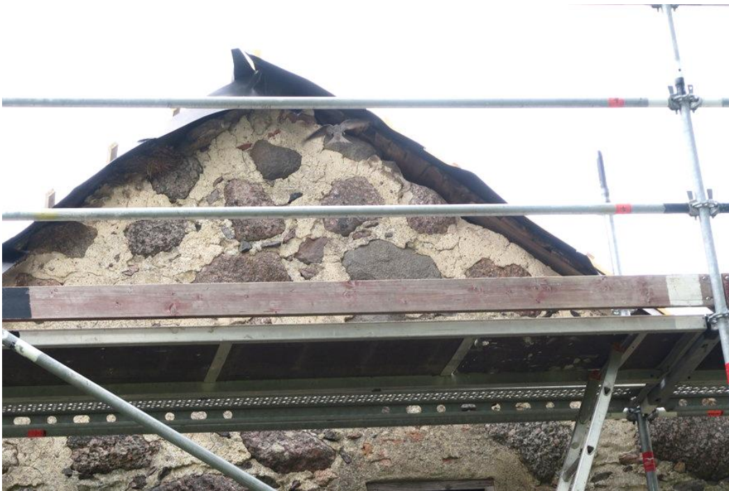
Vindskivor och täckbräden är bortplockade.
