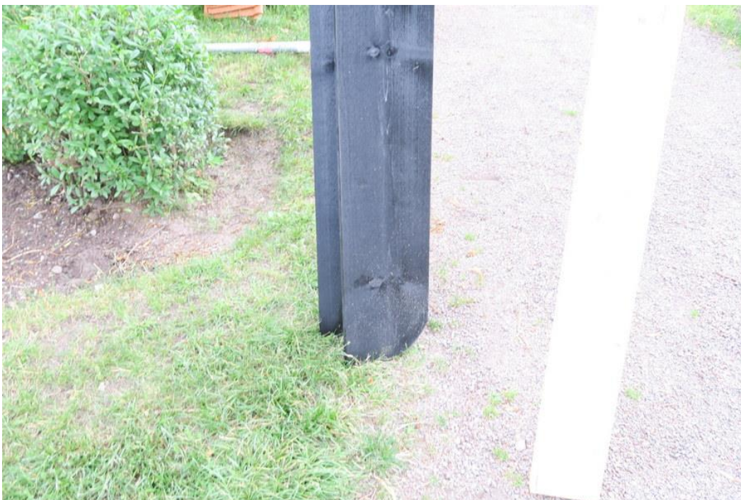
Nyttillverkade vindskivor där den undre brädan har en rundad avslutning enligt befintligt.
