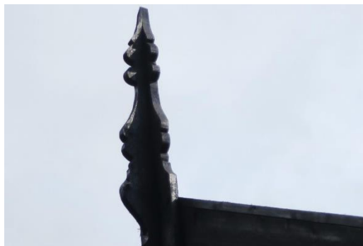
Dekorationerna på gavelspetsarna nytillverkades. Före, respektive efter takomläggning.
