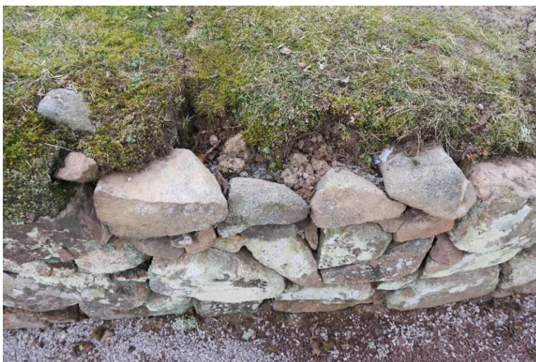
Del av mur, efter åtgärd.
