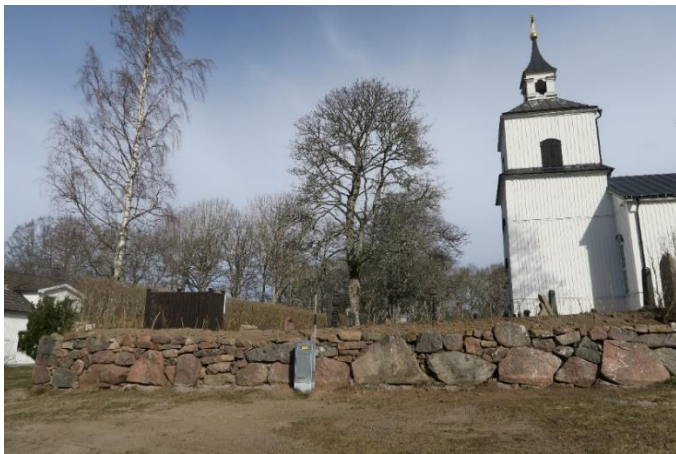
Södra murens västra del, efter åtgärd.
