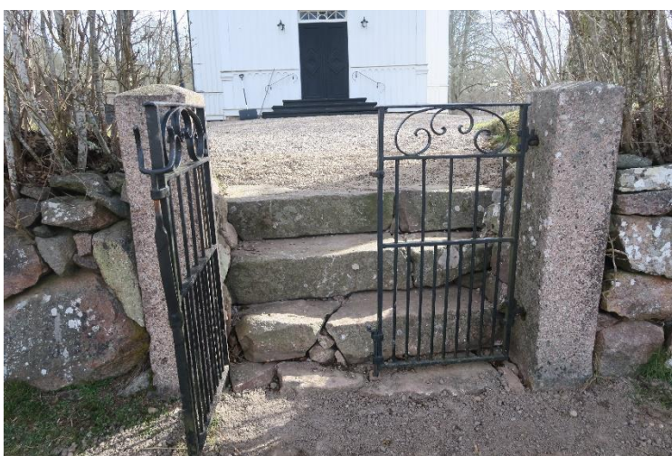
Trappavsats, mot öster.
