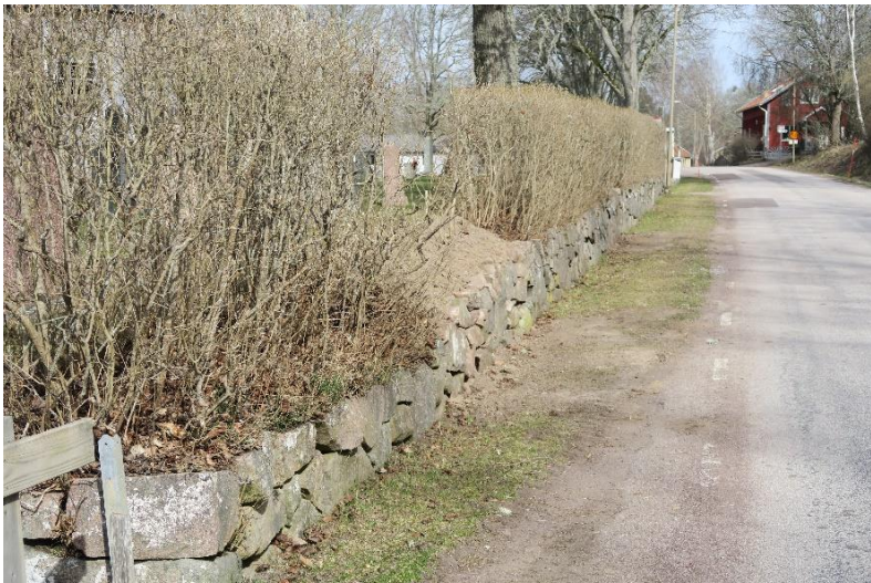
Östra muren, mot norr.
