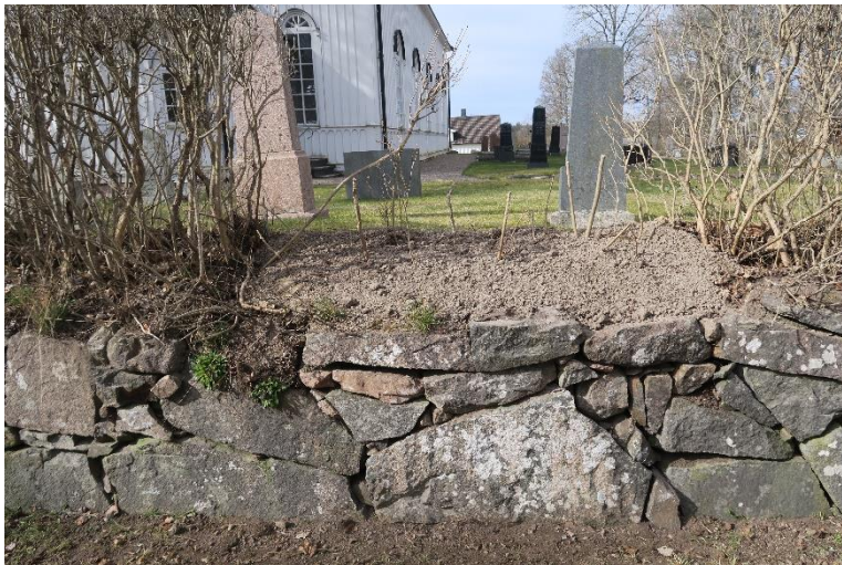
Parti mot norr, efter åtgärd.
