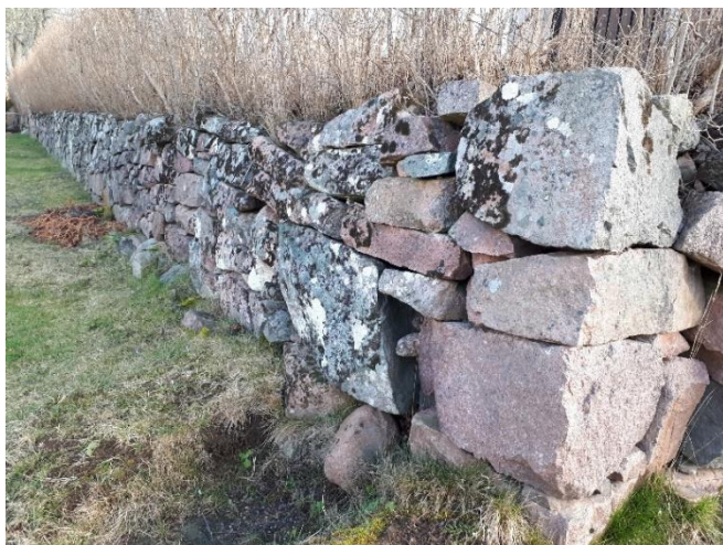
Västra muren, mot norr. Karin M.
