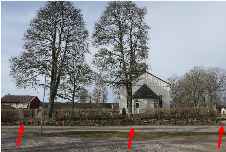
Tre partier har renoverats och markeras med pilar i bild.
