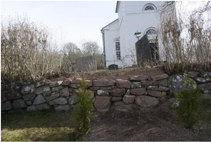
Västra muren, efter renovering.
