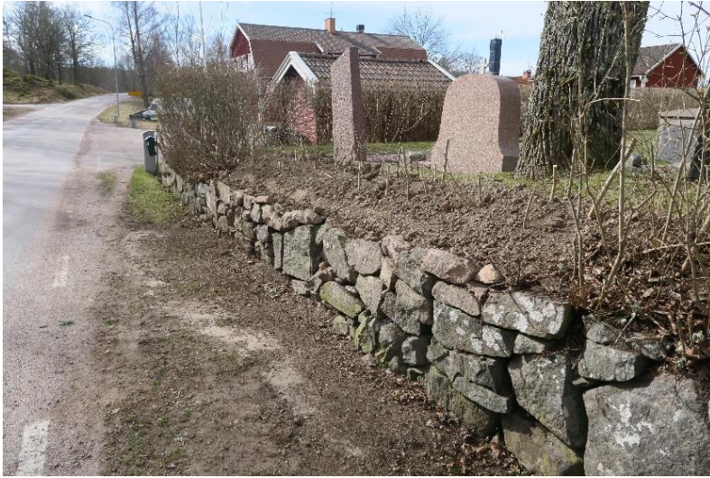
Parti mot söder, efter åtgärd.
