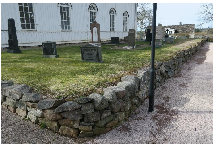
Del av mur, mot väster.
