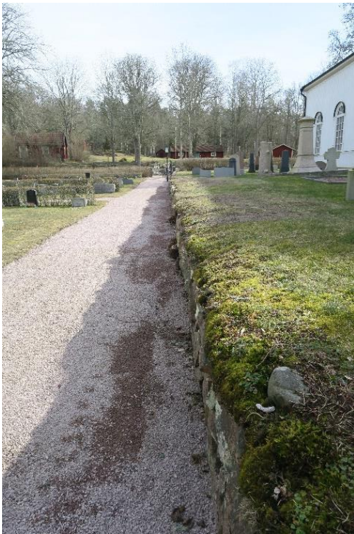
Mur med mossbeklädning, efter åtgärd.
