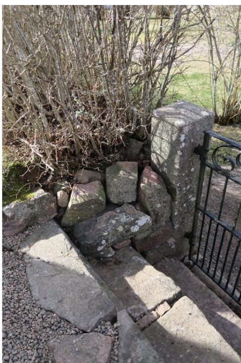
Trappavsats, efter renovering
