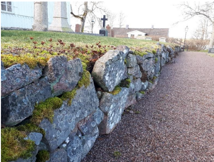
Norra muren, mot väster, in- för renovering. Karin M.
