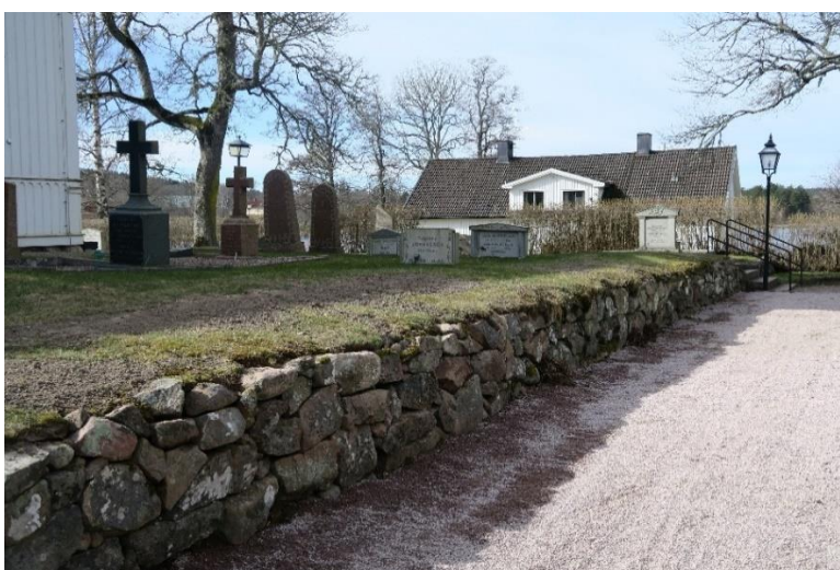
Mur mot väster, efter åtgärd.
