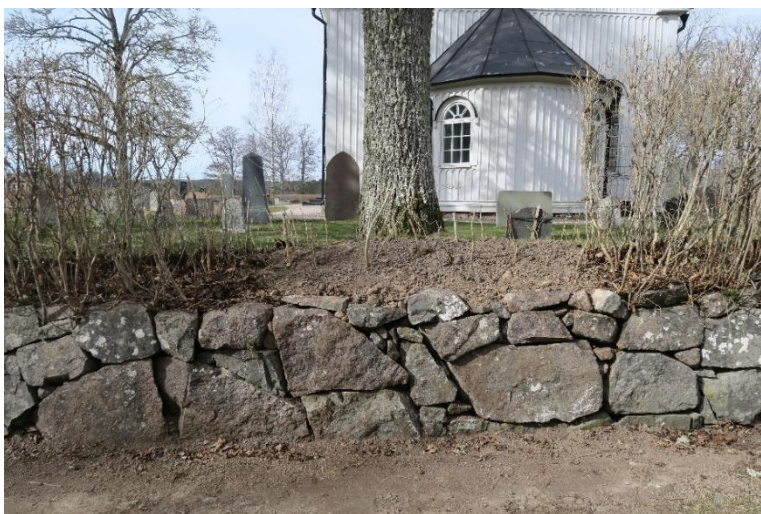
Mittenpartiet, efter åtgärd.
