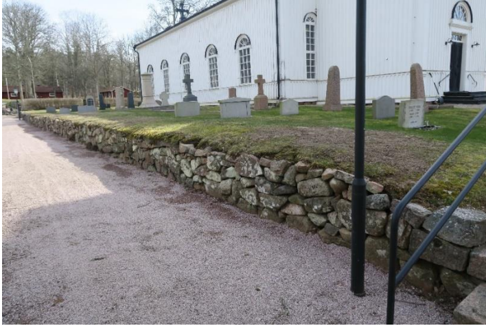
Norra muren, mot väster.
