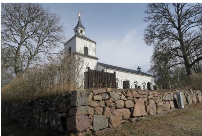
Södra muren, mot öster, efter åtgärd.
