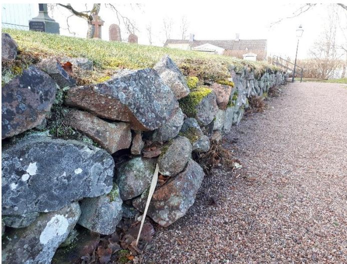
Norra muren, mot väster, in- för renovering. Karin M.
