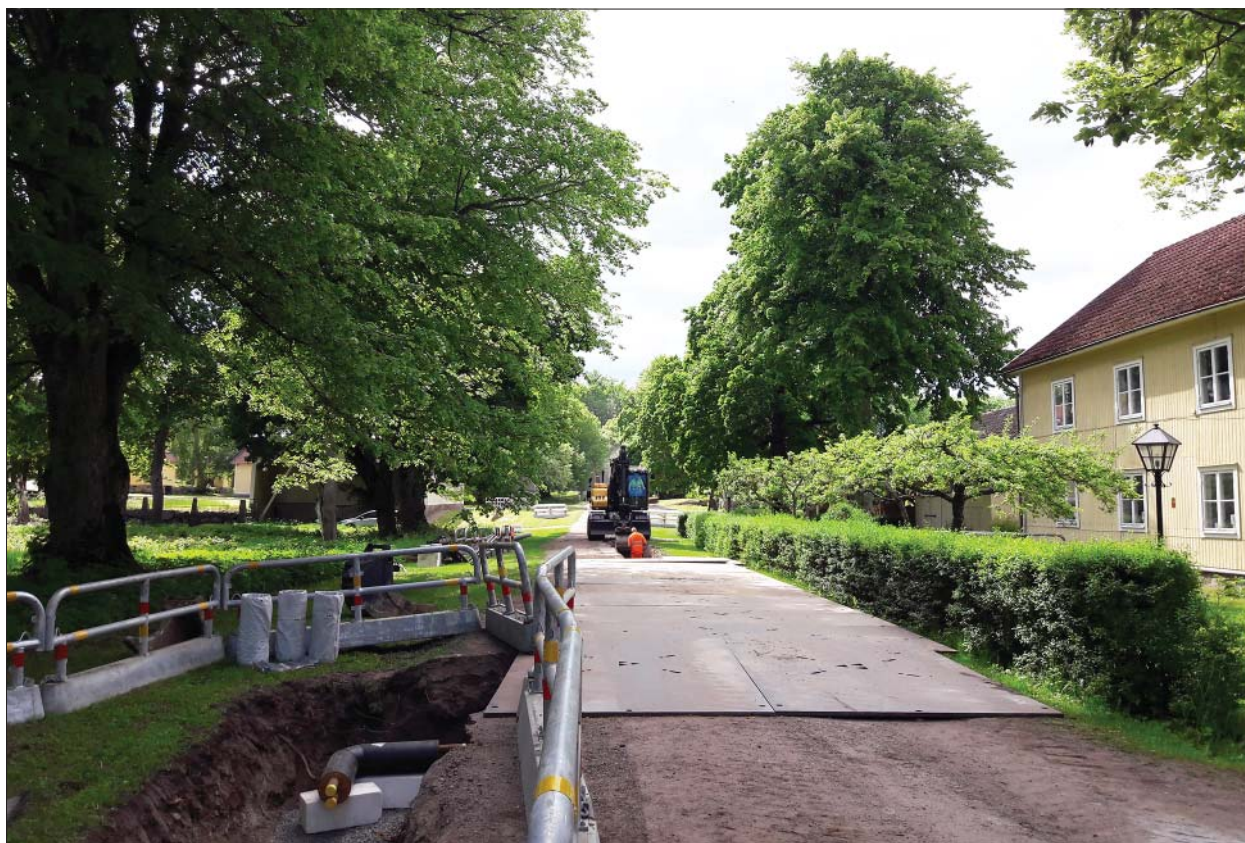
Figur 9. Schaktning pågår vid delsträcka 4. Foto mot V, Linnéa Hernqvist, ÖM.
